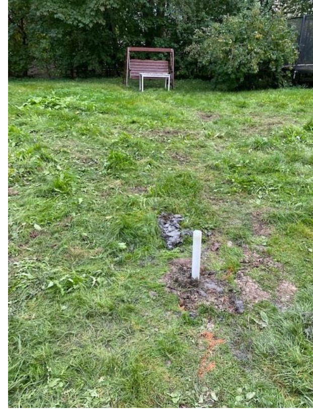
Bild 6: Provpunkt 1, installation av grundvattenrör.
