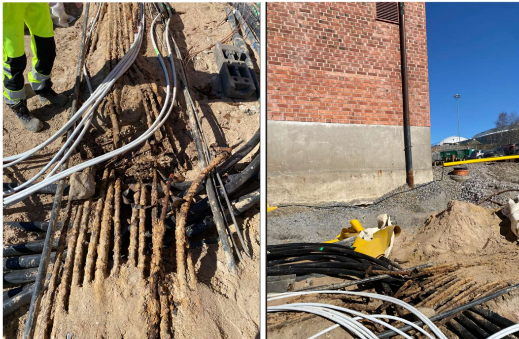
Figur 8- Kablar med olja och PCB som påträffades i anslutning till östra och södra delen av södra byggnaden på Isterbandet 5.
