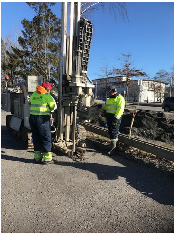
Figur 3 Provpunkt SW1904. En grundvattenrör installerades.
