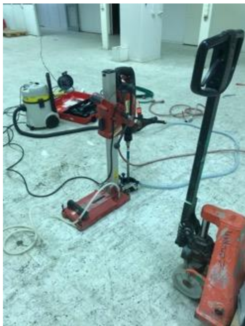
Figur 3 visar pågående betonghålslagning i bottenplattan hus 2 från den 12 november.
