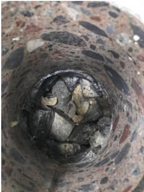
Figur 4 visar dräneringslagret som påträffades under bottenplattan innan finmaterialet.
