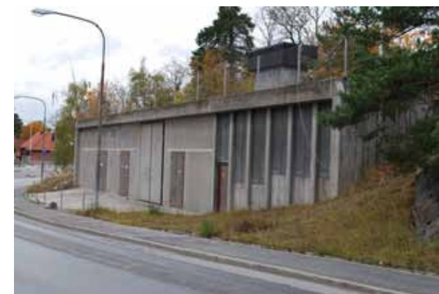
Figur 5.7.1 Transformatorstation på Björnnäsvägen. Stationen inrymmer SL:s likriktarstation och Fortums transformatorstation som försörjer tunnelbanan respektive närområdet med el.
