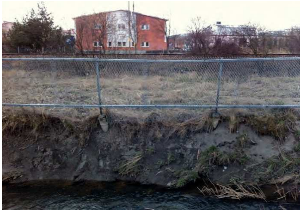
Figur 19. Genom erosion har Bällstaån vandrat allt närmare den befintliga banvallen.
