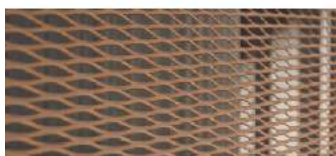
Sockelvåning Corténstål: Sträckmetall/ alt. perforerad plåt
