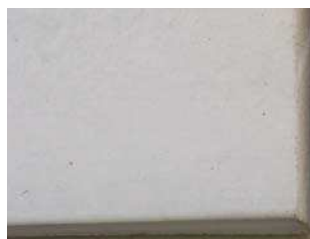
BILD 4:6:5 Slät betong i ljus kulör med precision i skarvar och hörn. Referens: kontorshus i kv. Mältaren, Rosenbergs arkitekter.
