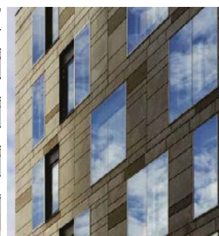
Infärgad betong som bildar horisontellt mönster och döljer elementskarvar. Exempel från kv 6a. Referens "Flat iron building" av Rosenbergs.
