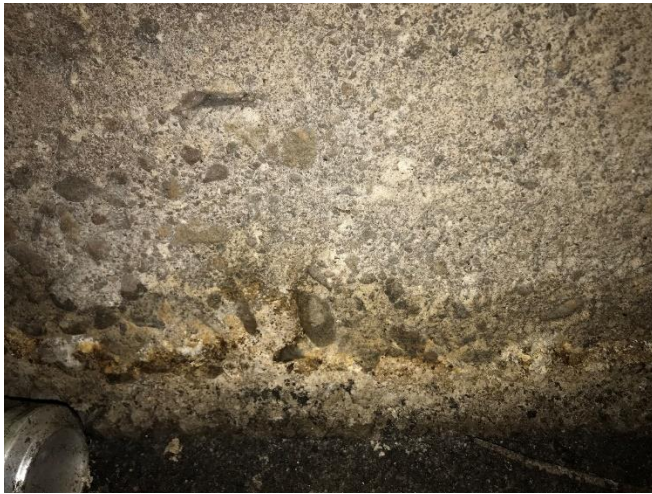
Figur 23: Porös betong på grund av urlakning.
