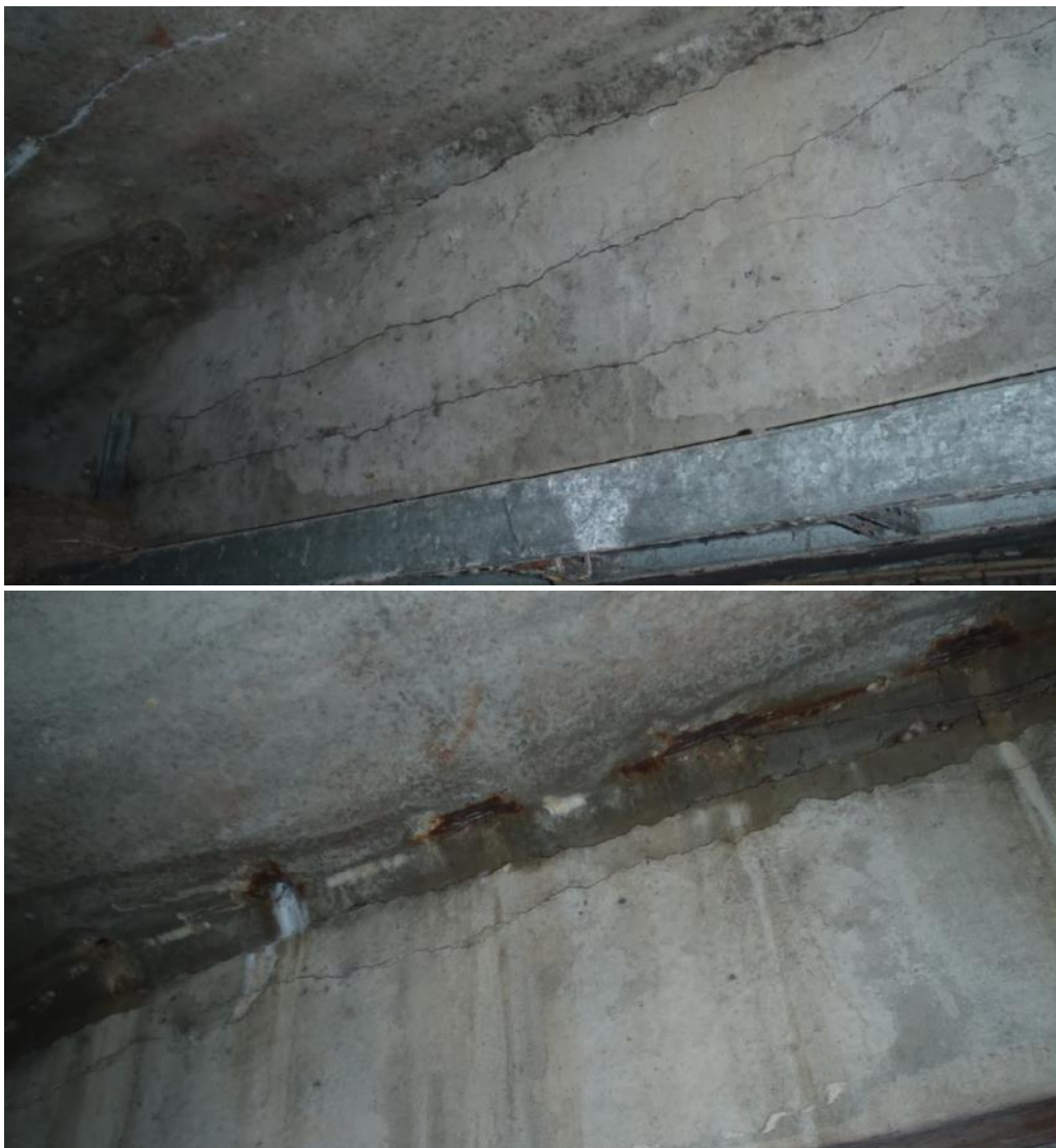
Figur 7: Foton på sprickor och spännlinor i TT-kassetter.
