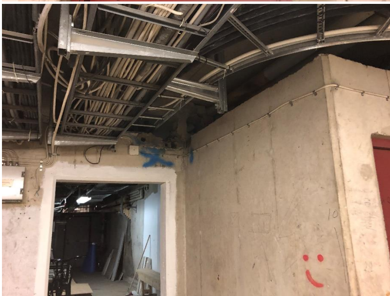
Figur 25: Kapning överkant betongväggshörn.
