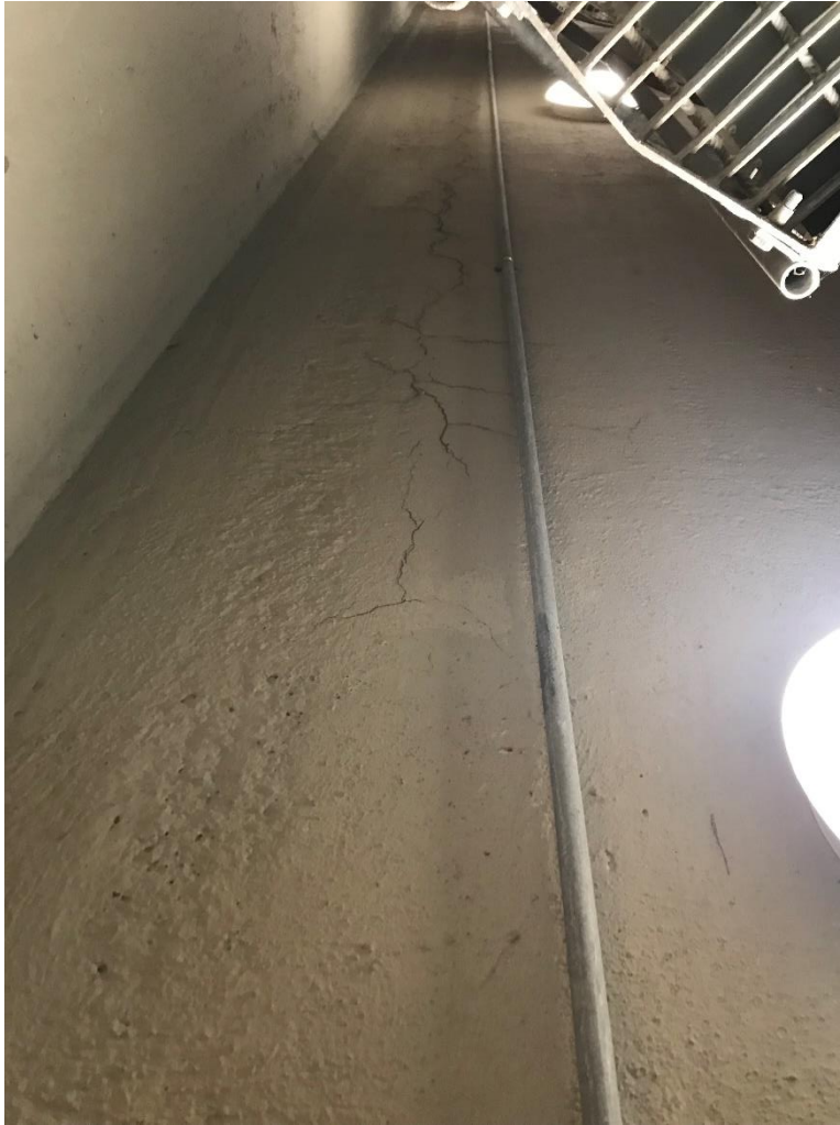
Figur 24: Längsgående spricka i trapphus.
