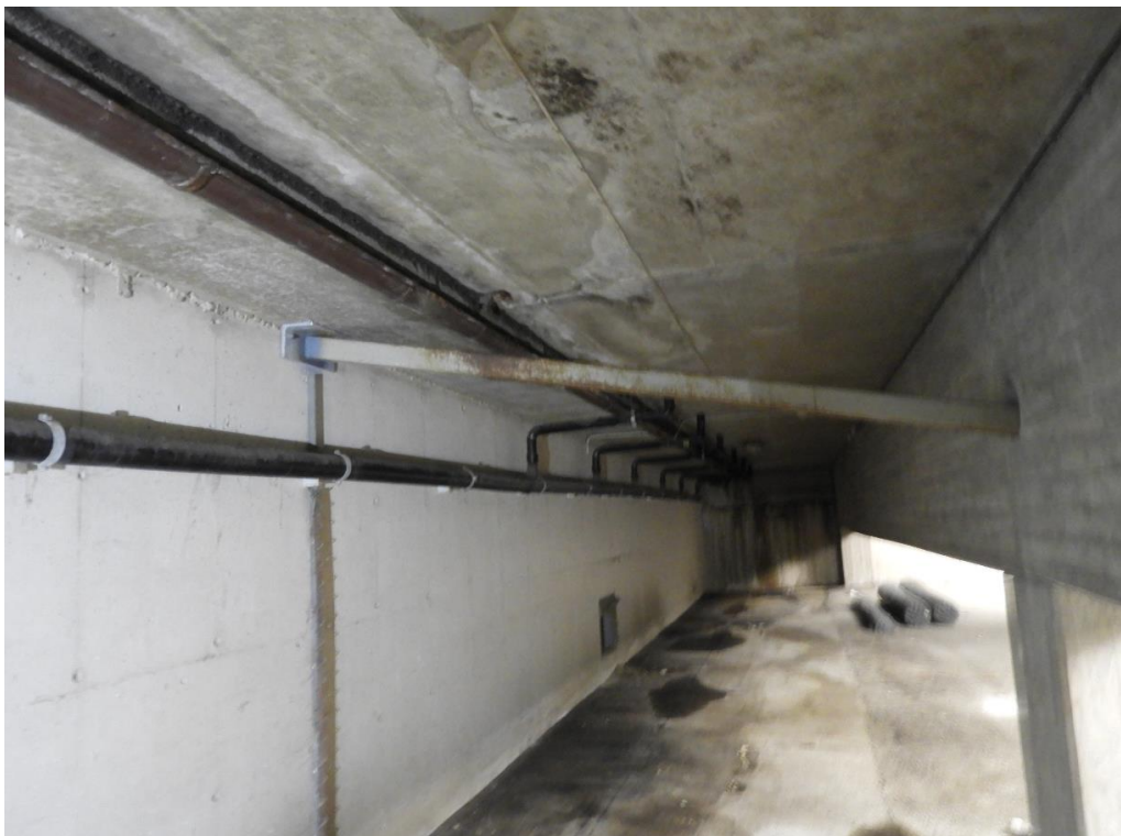
Figur 30: Läge för karbonatiseringsprover, betongvägg mot vatten samt balk.
