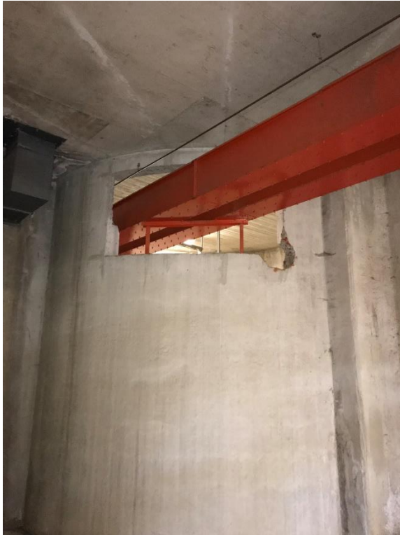
Figur 13: Håltagning i stomme vid tidigare ombyggnation.
