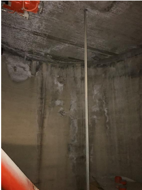
Figur 15: Vattengenomträngningar takbjälklag.
