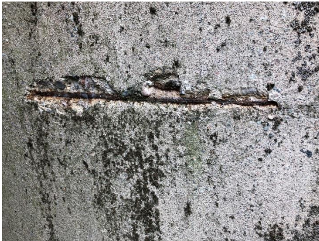
Figur 12: Ytligt placerad armering som korroderat.
