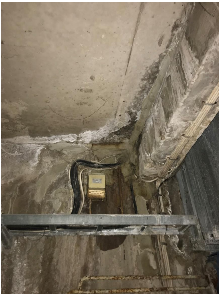
Figur 21: Vattengenomträngningar och kalkutfällning.
