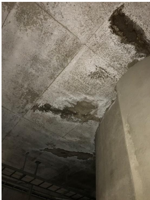
Figur 16: Vattengenomträngningar takbjälklag.
