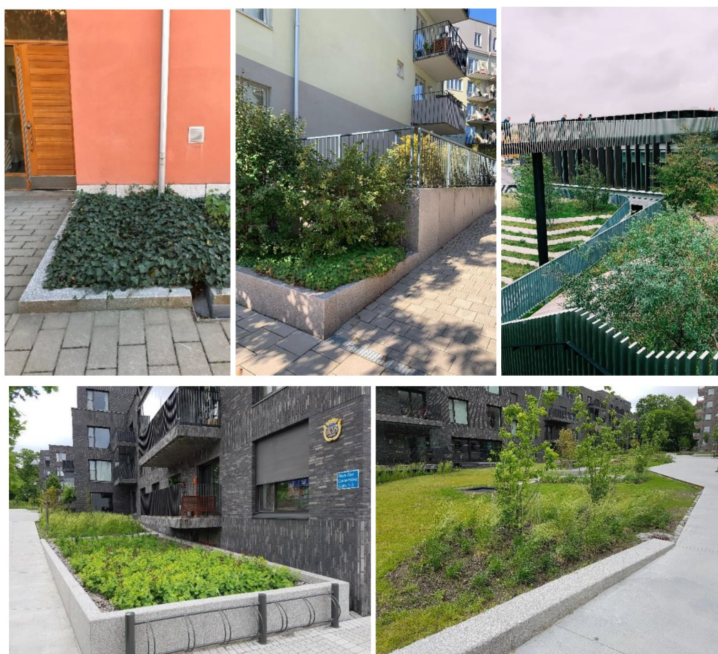
Figur 8. Principlösning upphöjda och nedsänkta regnväxtbäddar inom kvartersmark (Foto: Bjeking).
