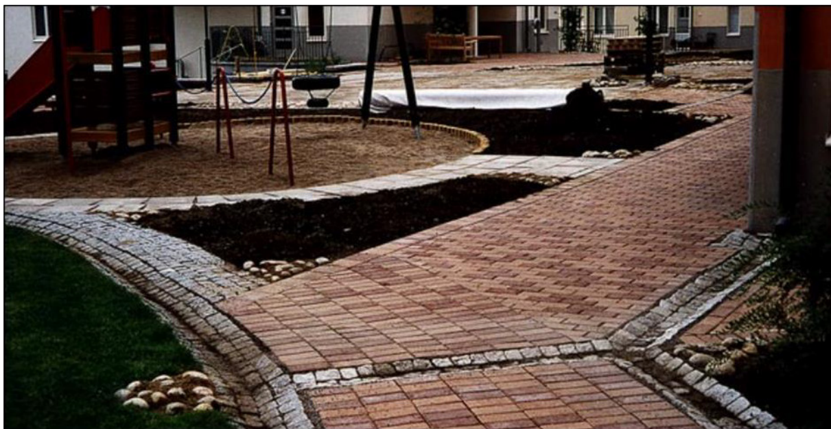
Figur 7-5. Exempel på avledning av takvatten via ränndalar anlagda med gatsten (Källa: Stockholm Vatten AB, n.d.).
