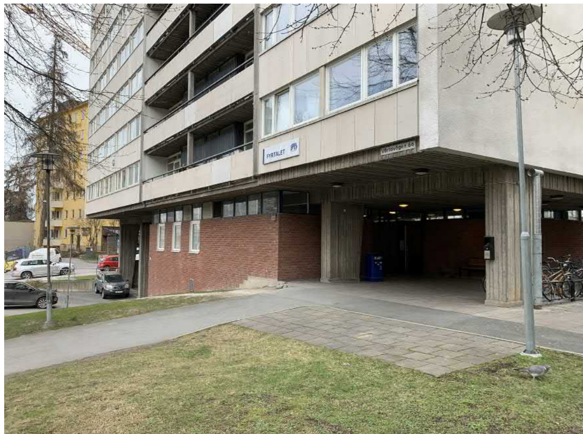
Huvudentrén är placerad till södra gavelsidan. Den överbyggda entrévåningen bildar en väderskyddad entréplats. Marken är påtagligt högre mot söder och ursprungligen fanns en trappa längs med fasad som överbyggde nivåskillnaderna. I teglet syns idag spår efter denna trappa.
