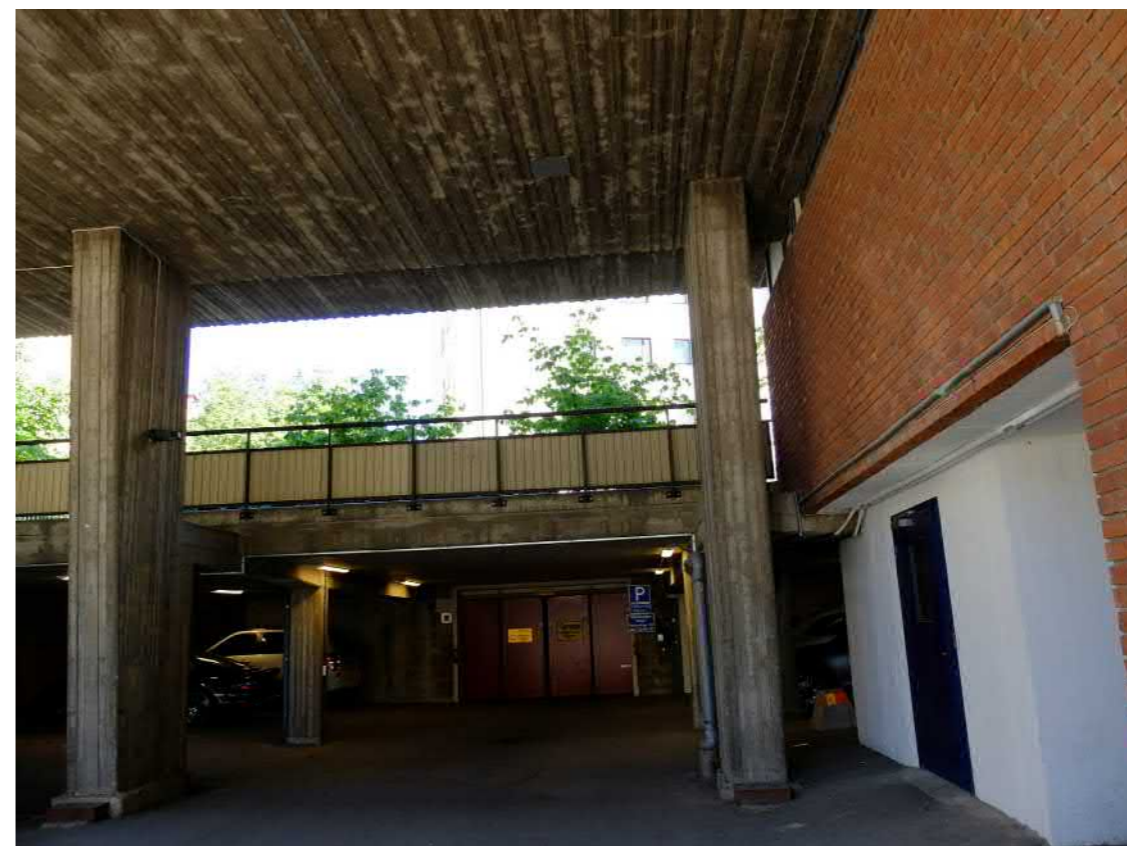
Garaget fortsätter under gården mot öster. Ett sekundärt räckle längs med östra sidan har reducerat in- och utblickar genom det öppna garaget. I garaget under norra gaveln har ursprungliga dörrar och portar bytts, fasadpartiet i betong har övermålat i vitt.
