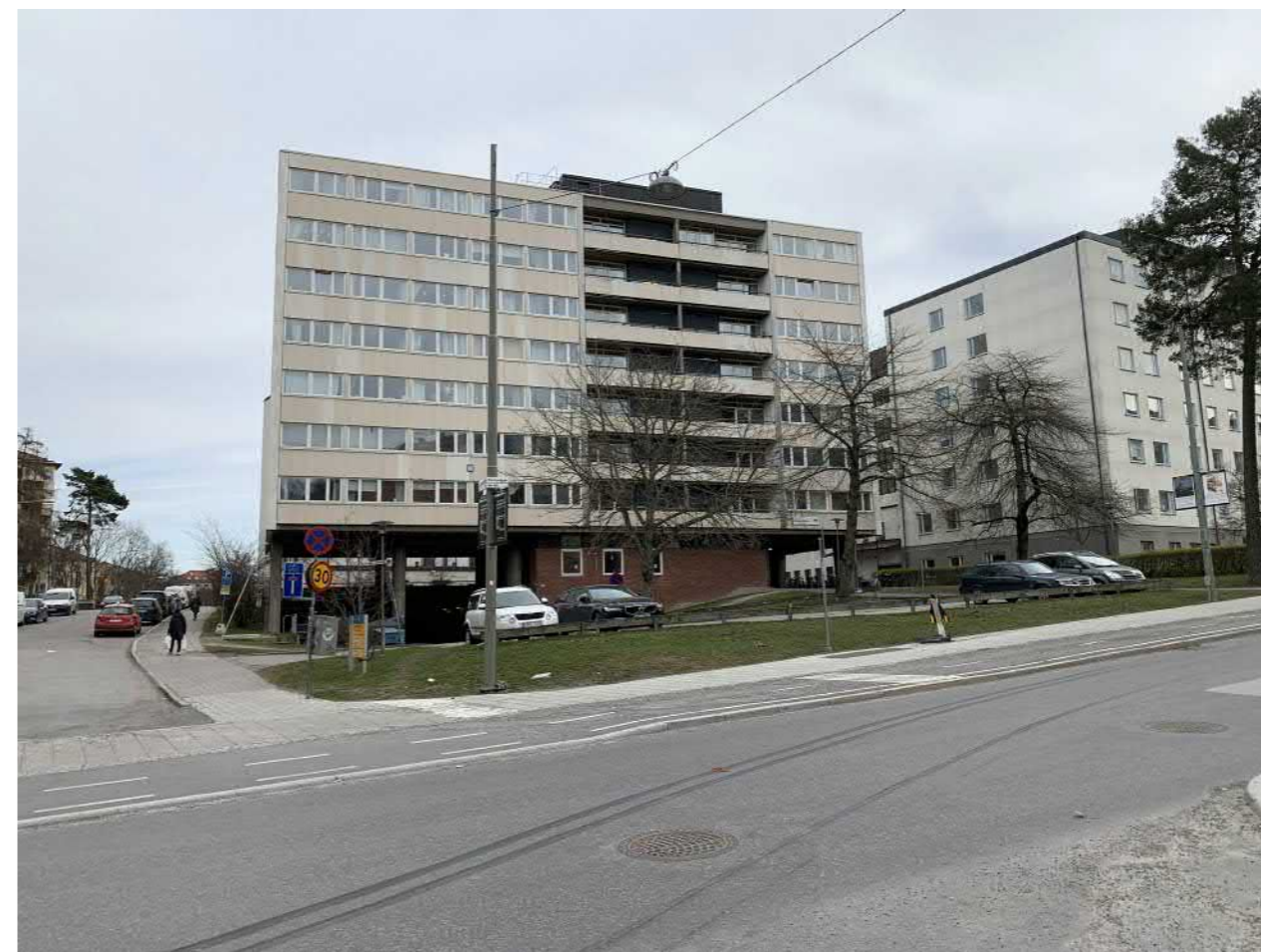
Byggnadens grundform, volym och höjd utgör ett av byggnadens främsta karaktärsdrag med en byggnadskropp som vilar på en djupt indragen entrévåning med överbyggt garage respektive huvudentré på var sida omgivandes synliga stompelare i betong.
