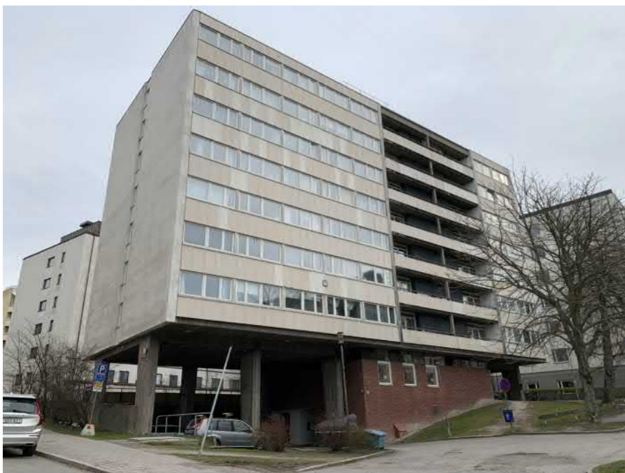
Bottenvåningens robusta tegel och formgjutna omålade betong kontrasterar mot de övre våningarnas maskinmässigt släta skivmaterial. Byggnadens fasad ovanför bottenvåningen karaktäriseras av slutna gråputsade gavelskivor samt ljusa långsidor med fönsterband, utfackningspartier i skivmaterial och indragna balkonger.
