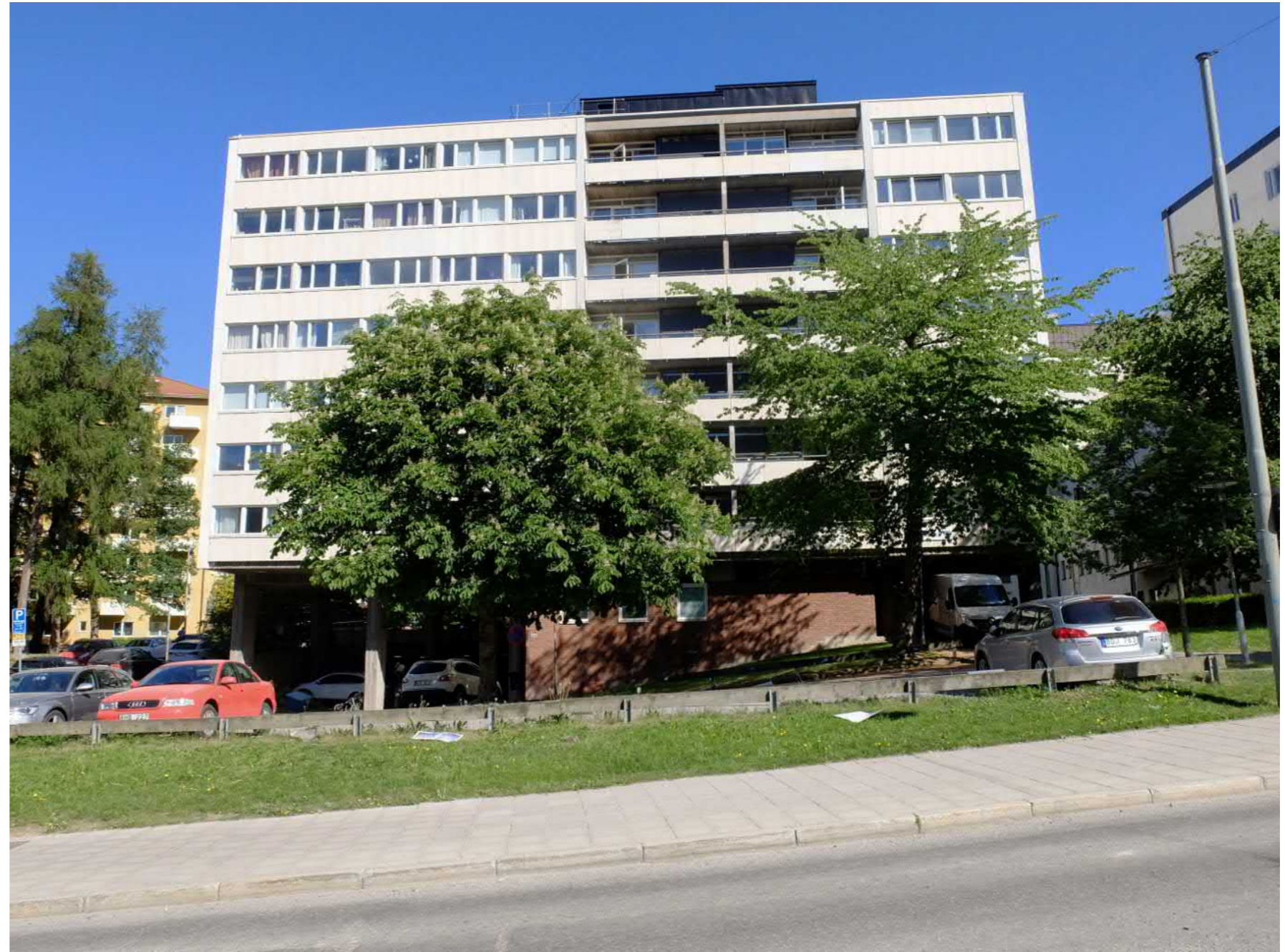
Byggnaden vilar delvis på höga betongpelare och delvis på en indragen tegelklädd entrévåning. Fasadrenoveringen som utfördes i samband med tilläggsisoleringen på 1990-talet påverkade inte byggnadens karaktär på ett betydande sätt. Förgårdsmarken mot Värtavägen består av en asfalterad parkeringsyta med omgivande gräsmatta och vegetation i form av tall och lövträd.
