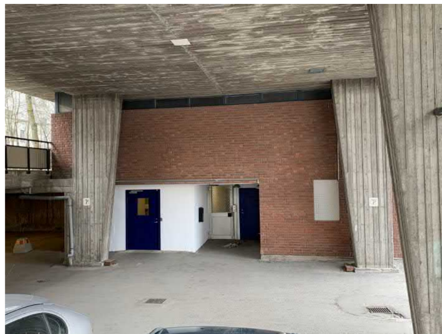
Ursprungligt tegel i botten- och källarvåning, undertak, väggar och fristående pelare med avsmalnad form i mönstergjuten omålade betong. Ursprungliga fönsterpartier i fönsterband i blåmålat trä och stål.
