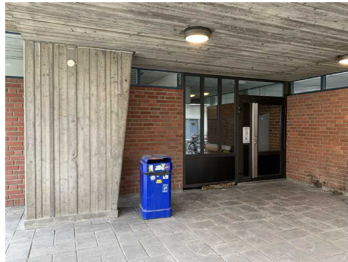
Huvudentrén mot söder. Entréparti i bruneloxerad aluminium är sekundärt men har en likartad indelning som originalentrén. Markbeläggningen bestående av rektangulära betongplattor lagda i geotermiskt mönster är original.
