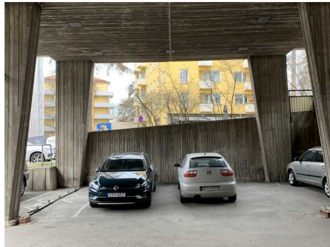
Pelare, undertak och sidoväggar i formgjuten, omålad betong.
