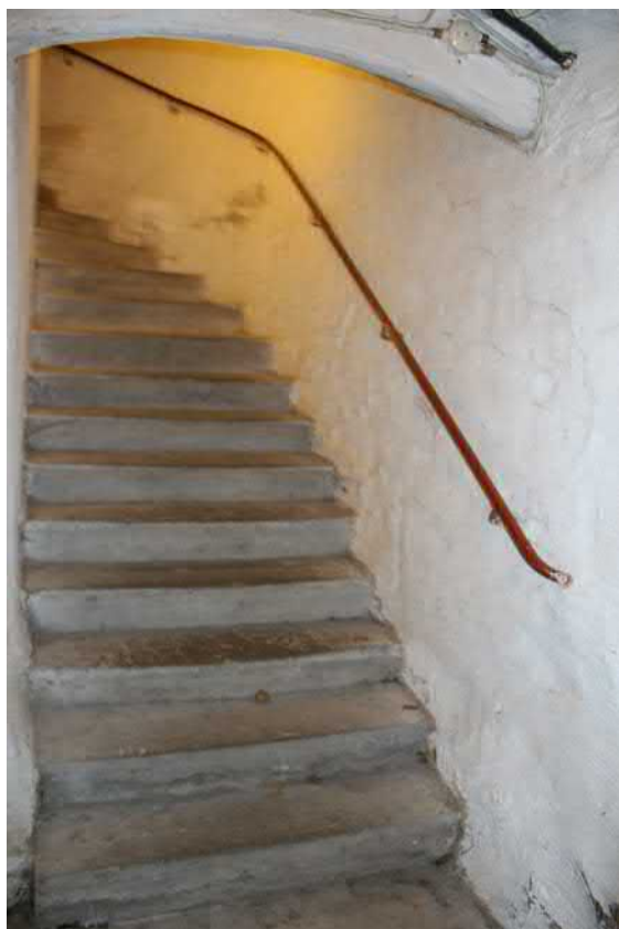
Ursprunglig källartrappa med trappledare i trä.
