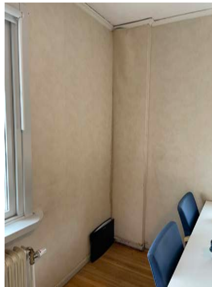
Vattenskada i hörn på nedre plan.
