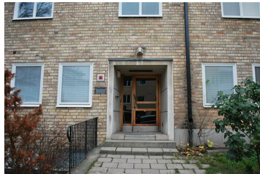
Båda portikerna är kraftigt indragna i fasaden och har putsade omfattningar med kopparöverstycken. Ursprunglig portbelysning sitter ovan entréerna i form av en trekantig lampa som anger portnummret med svarta siffror.
