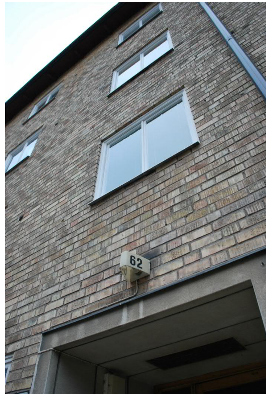
Den ojämnt brända teglet murat i förband skapar nyanseringar och livfullhet i fasaden.
