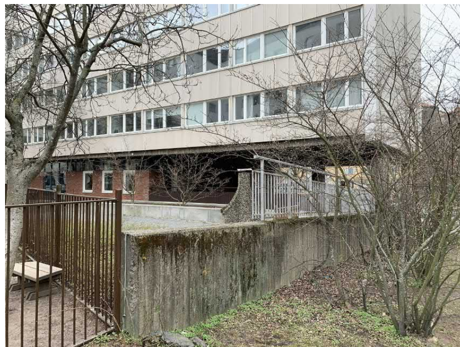
Formgjuten betongmur mot Sandhamnsgatan.
