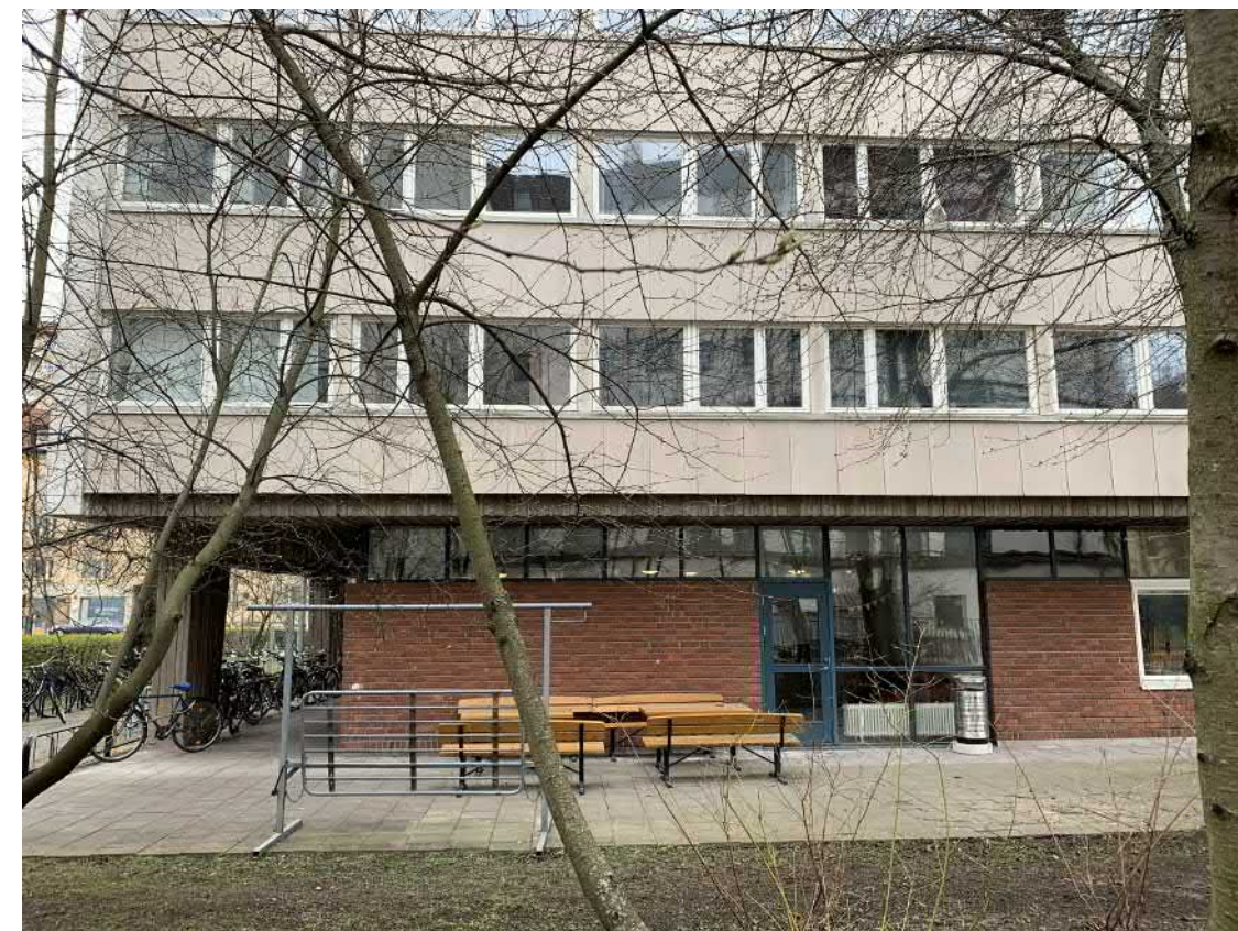
Fasad mot gården med entré till föreningslokalen. Den glasade trädörren är sekundär och fönster med vita karmar tillkom 2011 när entréväningen inreddes med två studentlägenheter vilket har påverkat fasaduttrycket negativt.
