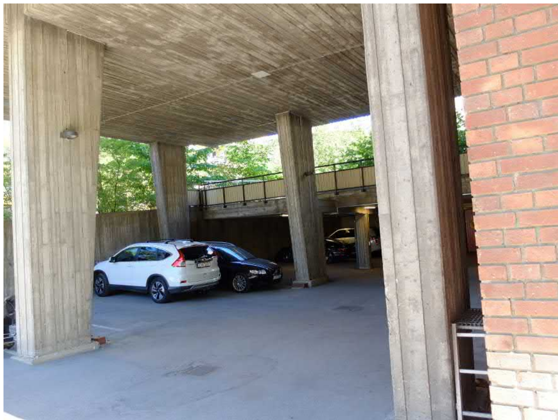
Marken i garaget är asfalterad och fundamenten har krupit upp något. Ursprungliga kvadratiska belysningsarmaturer i taket har avlägsnats och utrymmena har täckts för. Nya belysningsarmaturer har monterats på pelarna.
