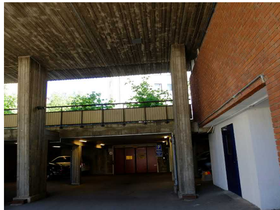
Garaget fortsätter under gården mot öster. Ett sekundärt räcke längs med östra sidan har reducerat in- och utblickar genom det öppna garaget. I garaget under norra gaveln har ursprungliga dörrar och portar bytts, fasadpartiet i betong har övermålat i vitt.
