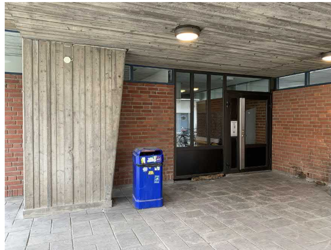
Huvudentrén mot söder. Entréparti i brunloxerad aluminium är sekundärt men har en likartad indelning som originalentrén. Markbeläggningen bestående av rektangulära betongplattor lagda i geotermiskt mönster är original.
