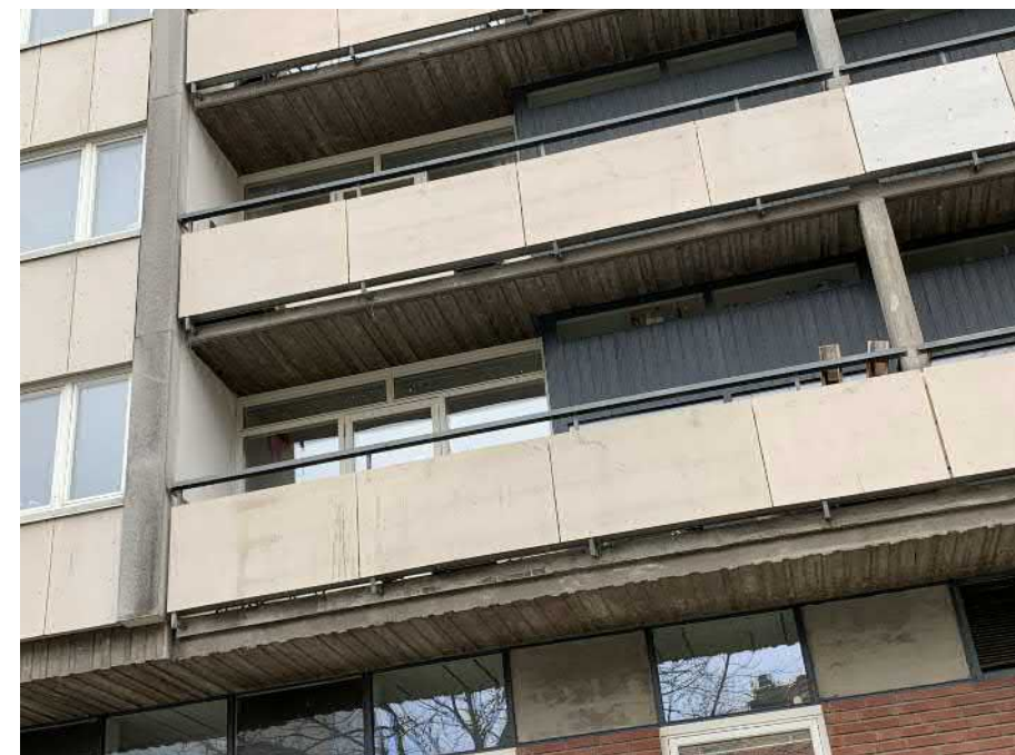
Cementfiberskivor i utfackningspartier och balkongfronter samt fönster och balkongdörrar är sekundära men bevarar i hög grad ursprunglig karaktär. Panelklädda balkongväggar, balkongplattor och blå fönsterband är original.
