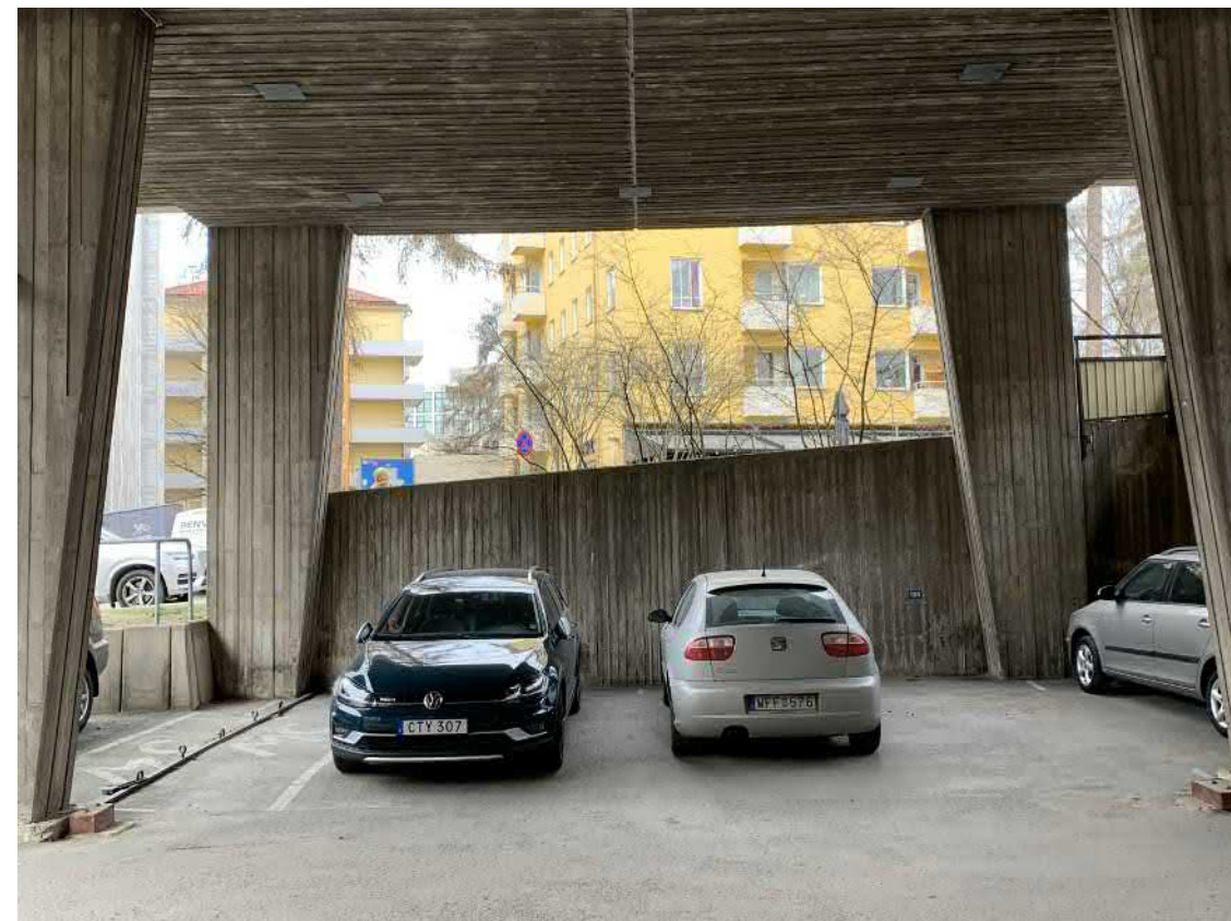
Pelare, undertak och sidoväggar i formgjuten, omälad betong.
