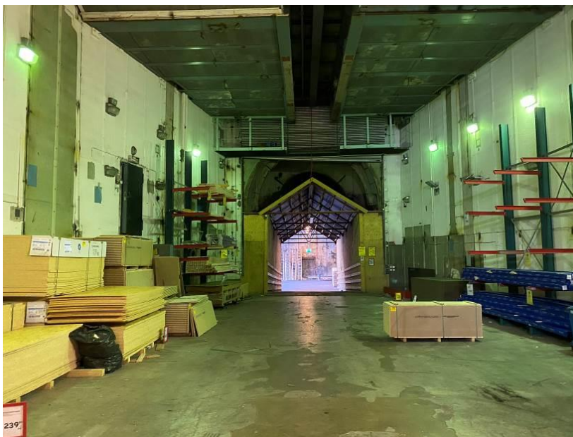
Jetmotorprovhuset består i en verkstadsdel där motorerna monterades samt en långsmal provcell samt utblåsningsdelen längst bort i bild.
