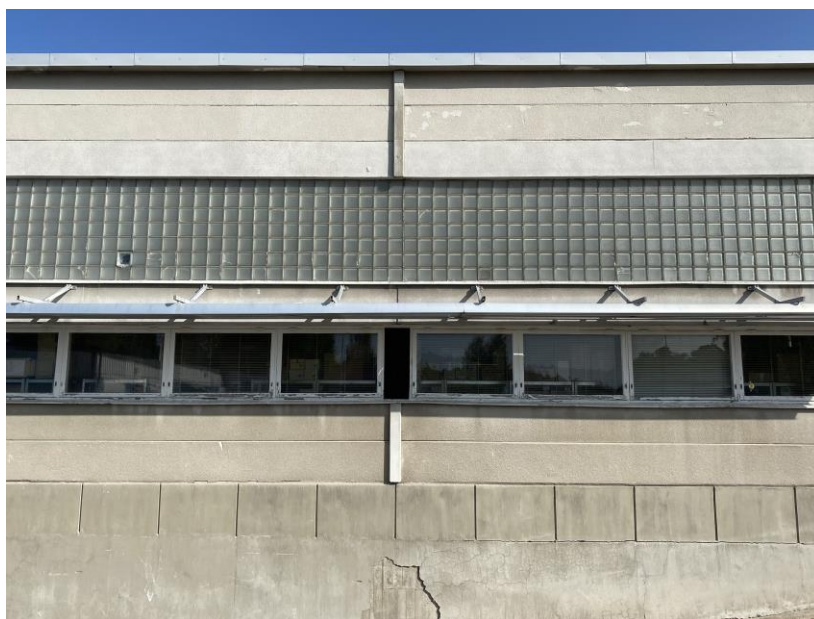
Apparatverkstadens fasad med betong- och glasbetongpartier.
