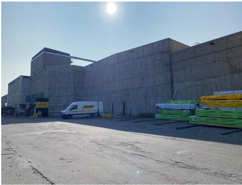
Fasaderna består av betong vilken är bearbetad med ett ingjutet mönster.
