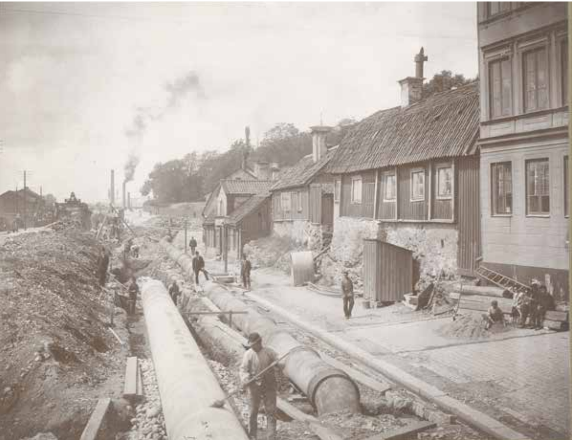
Nedläggning av avlopps- och gasledningar längs med Torsgatan, 1897. Stockholmskällan.
