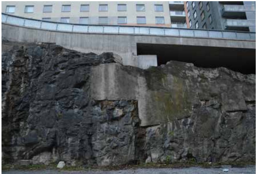
Bergsskärningen inom kvarteret Öskaret. Förstärkningar i betong har gjorts för att klara tunga laster från väg och bro.
