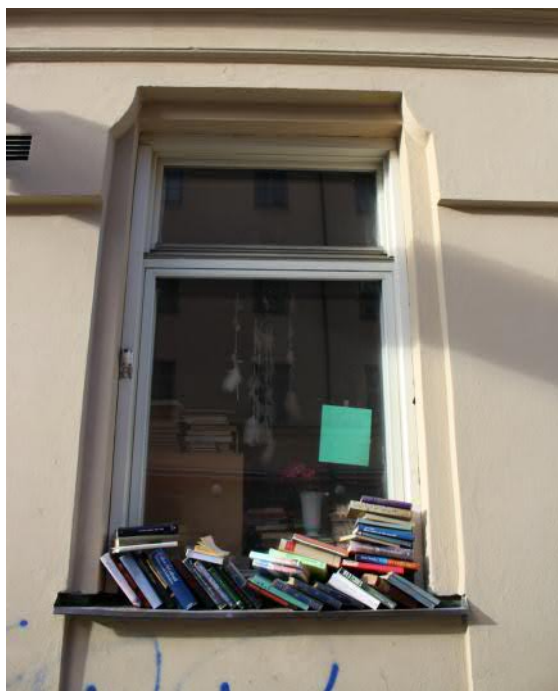
Fönster i bottenvåningen har bytts ut till tvåluftsfönster utan mittpost och spröjs. Fönsternischens insvängda form i övre delen är sannolikt formad efter de putspilstrar som ursprungligen smyckade entréfasaden.
