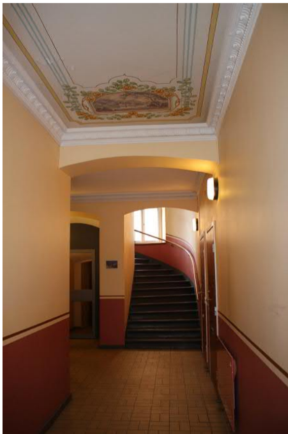
< Trapphuset har delvis sekundära ytskikt med målad väggbård och klinkergolv.
