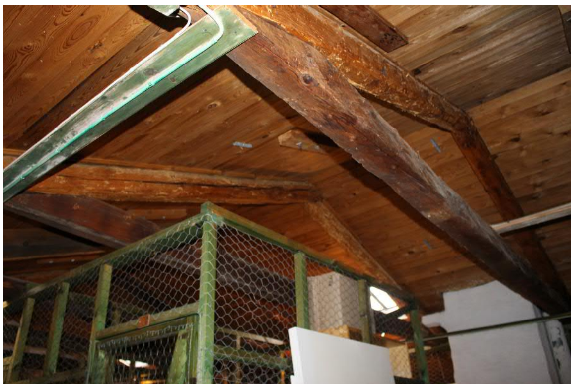
Takstol och takpanel är exponerad på vinden.
