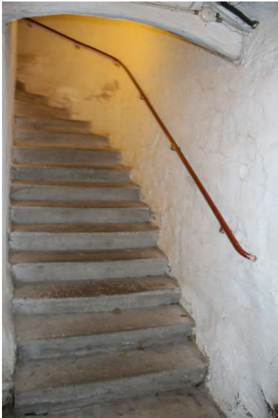
Ursprunglig källartrappa med trappledare i trä.
