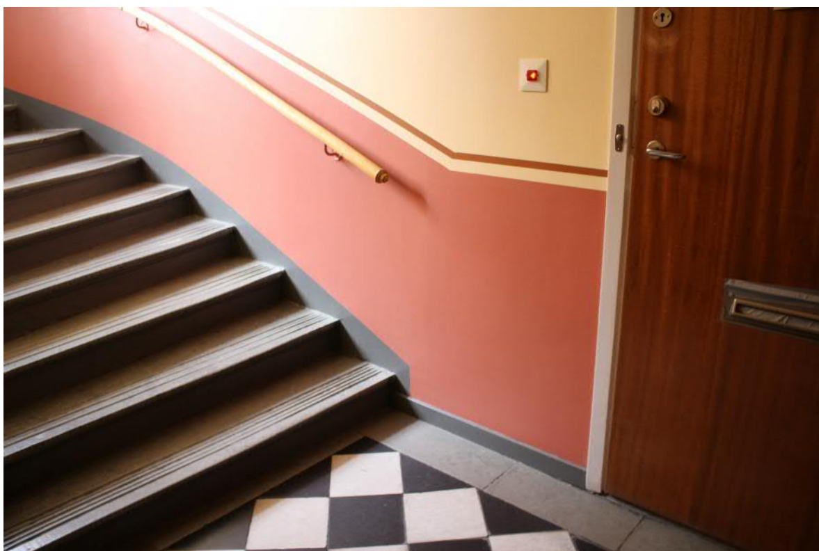
Trappa i övre våningsplan har trappsteg i räfflad kalksten.
