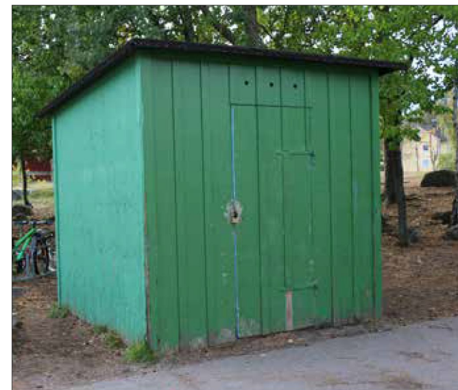
Uteförråd med locklistpanel och pulpettak. Okänt byggår.
