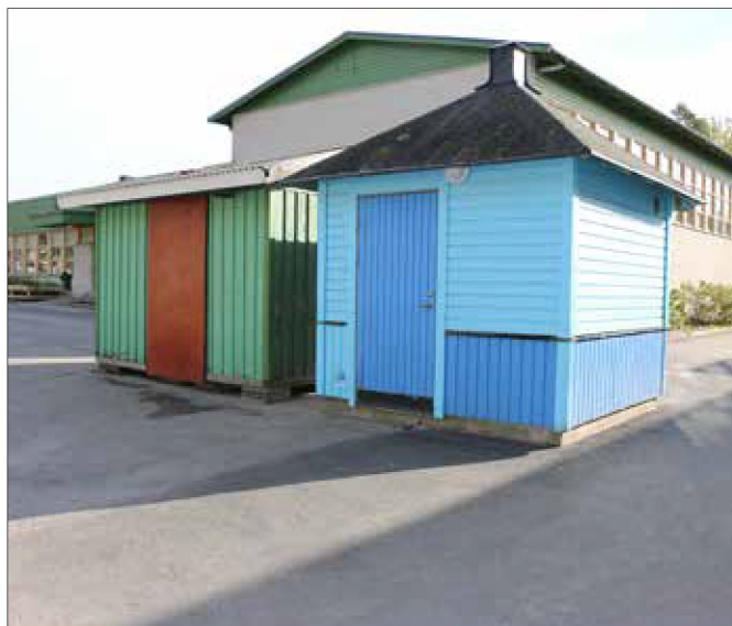
Pumphus med liggande och stående panel med pyramidtak täckt shingel. Okänt byggår.
