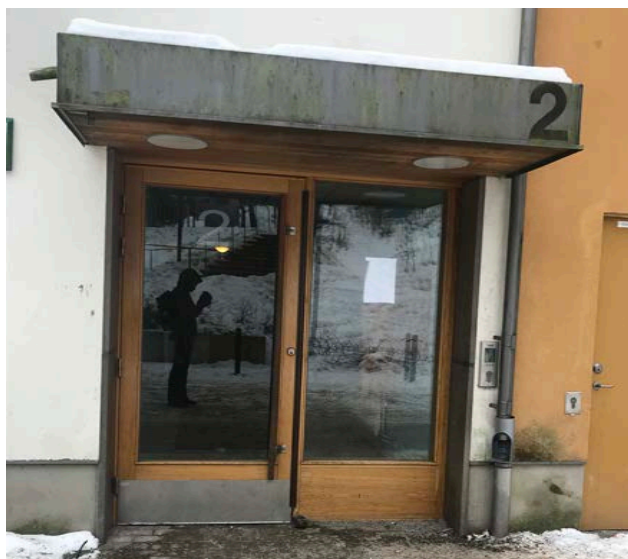
Portar i trä med stora glaspazier. Portar i liv med fasad med omfattning i natursten, krönt av ett robust skärmtak
