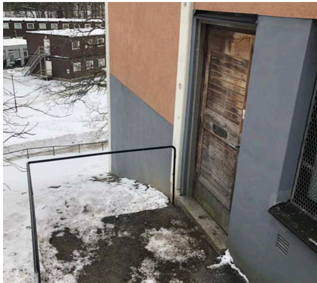
Äldre källardörr i liggande panel på souterrängvåning. Sockel i gråmålad betong. anslutande trappa i granit med ursprungligt räcke i smide.
