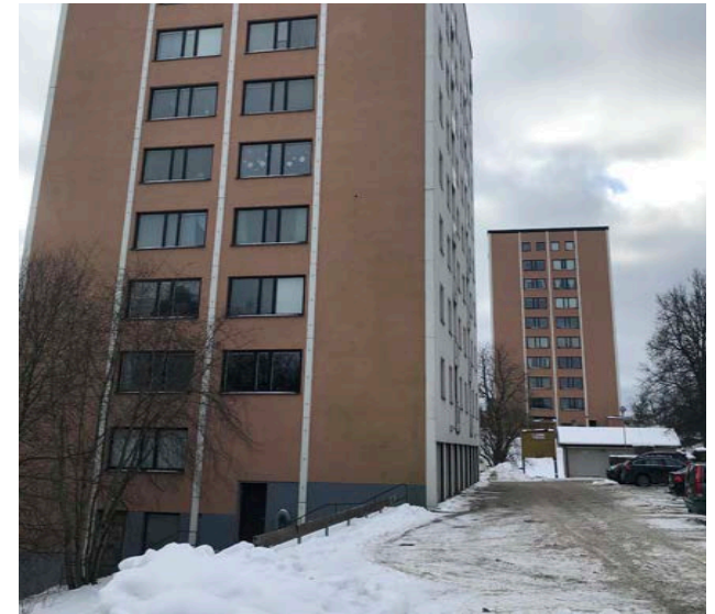
Kortsidor i en aprikosfärg. Förestena delas av av senare tillkomna vertikala. Treluftsfönster med bruna karmar och bågar i plåt.
