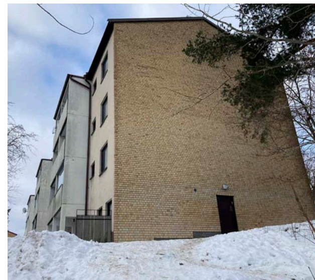
Utanpåliggande balkonger med fronter samt heltäckande sidodskydd från mark till tak i vitmålad betong. Gavel i gul fasadtegel. Flackt sadeltak utan takutsprång.
