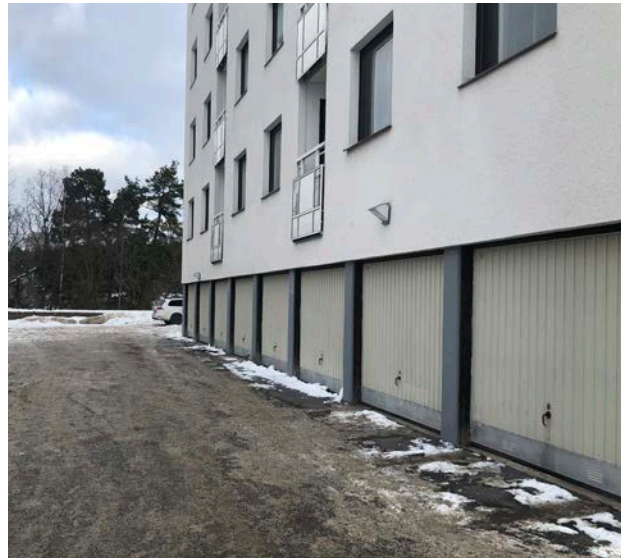
Inbyggda garage är ett typiskt inslag i 1960-talets flerbostadshus. Längsidoer i vit puts. Väggar tilläggsisolerade.
