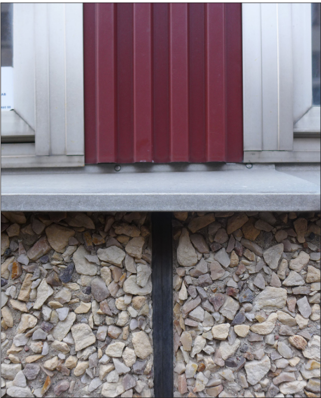
Skolanläggningens huvudsakliga material: betongelement med frilagd ballast, aluminium och röd korrugerad plåt.
