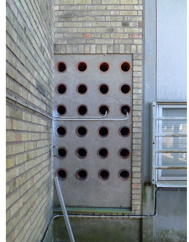
På ett par ställen i fasaden finns luftintag i form av flertalet liggande tegelrör ingjutna i betong.
