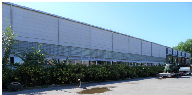
Verkstäderna har fasader av lättbetongplank, ljusinsläpp av breda betongglaspartier samt fönsterband.
