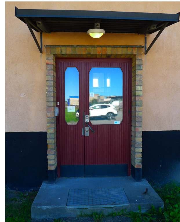
Byggnaderna har hög kvalitet i material och utförande, med bland annat gjuten grund, tegelomfattningar och entrédörrar av karosseripanel.
