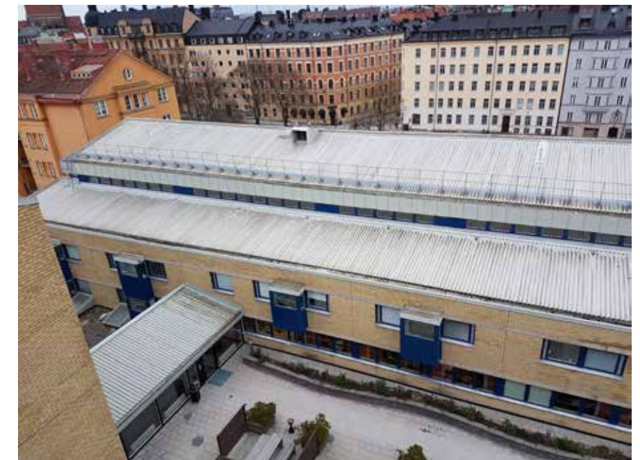
Taken är täckta med omålad korrugerad plåt.
