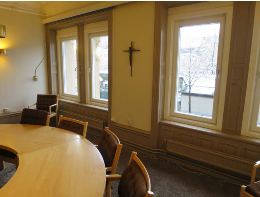
Ursprunglig fönsterbröstning och paneler runt fönster mot gatan. Fönstren är från 1940-talet med tidsenliga beslag.
