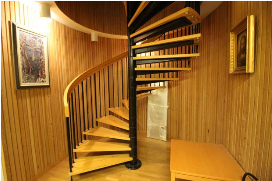
Spiraltrappa upp till gemensamhetsutrymmen på våning 5 tr är utformad i stål med trädetaljer och omges av väggar med träpanel. Trappan härrör från 1980-talets ombyggnation och har vissa arkitektoniska kvaliteter.
