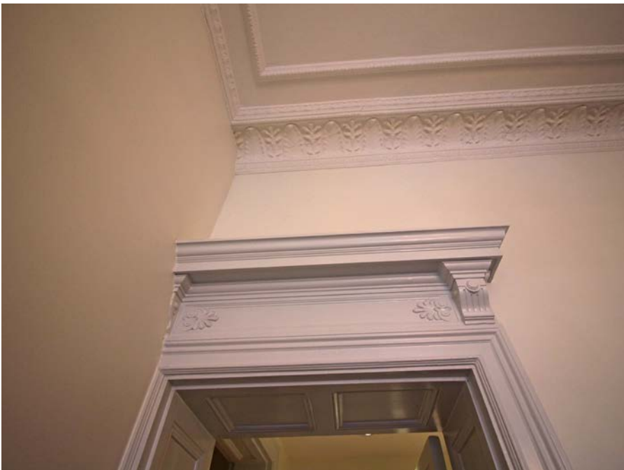
Placeringen av en sekundär mellanvägg har inneburit att del av dörröverstycke och dörrfoder kapats.
