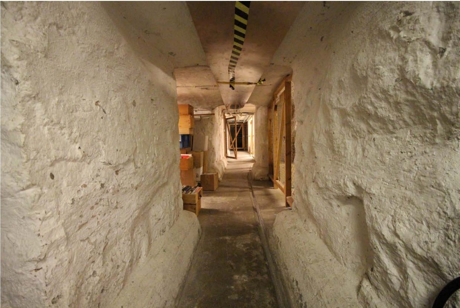
Källargång i ursprungligt läge med slammade murväggar som utgör del av den ursprungliga stommen.
