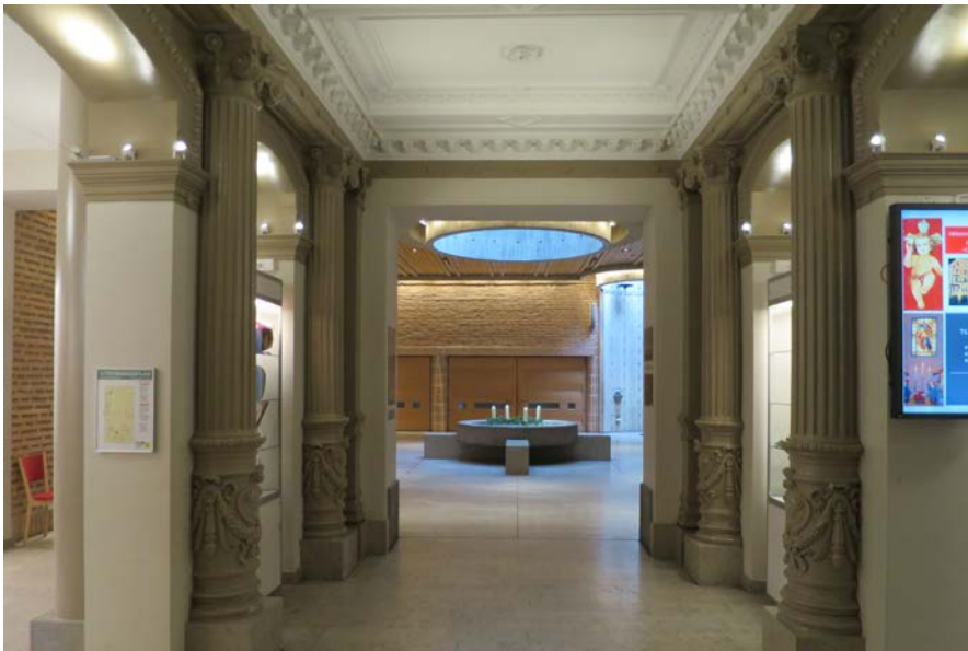
Arkader i entréhallen med murade pelare och kolonner i gjutjärn och riklig stuckdekor i taket. Marmorgolvet lades in på 1980-talet och fortsätter genom kyrktoget.
