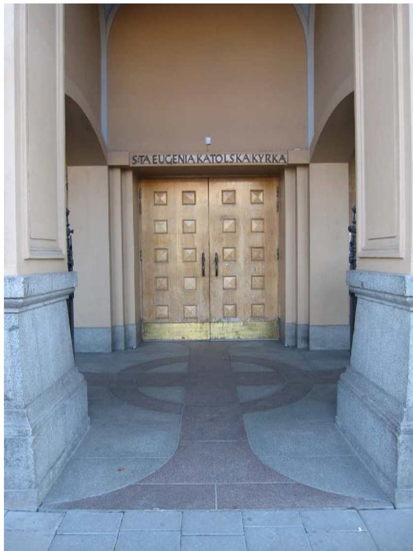
Entrédörrar i trä med fasetter, sparkskydd i mässing och trycken i brons. Markbeläggning i grå granit med ringkors i röd granit.
