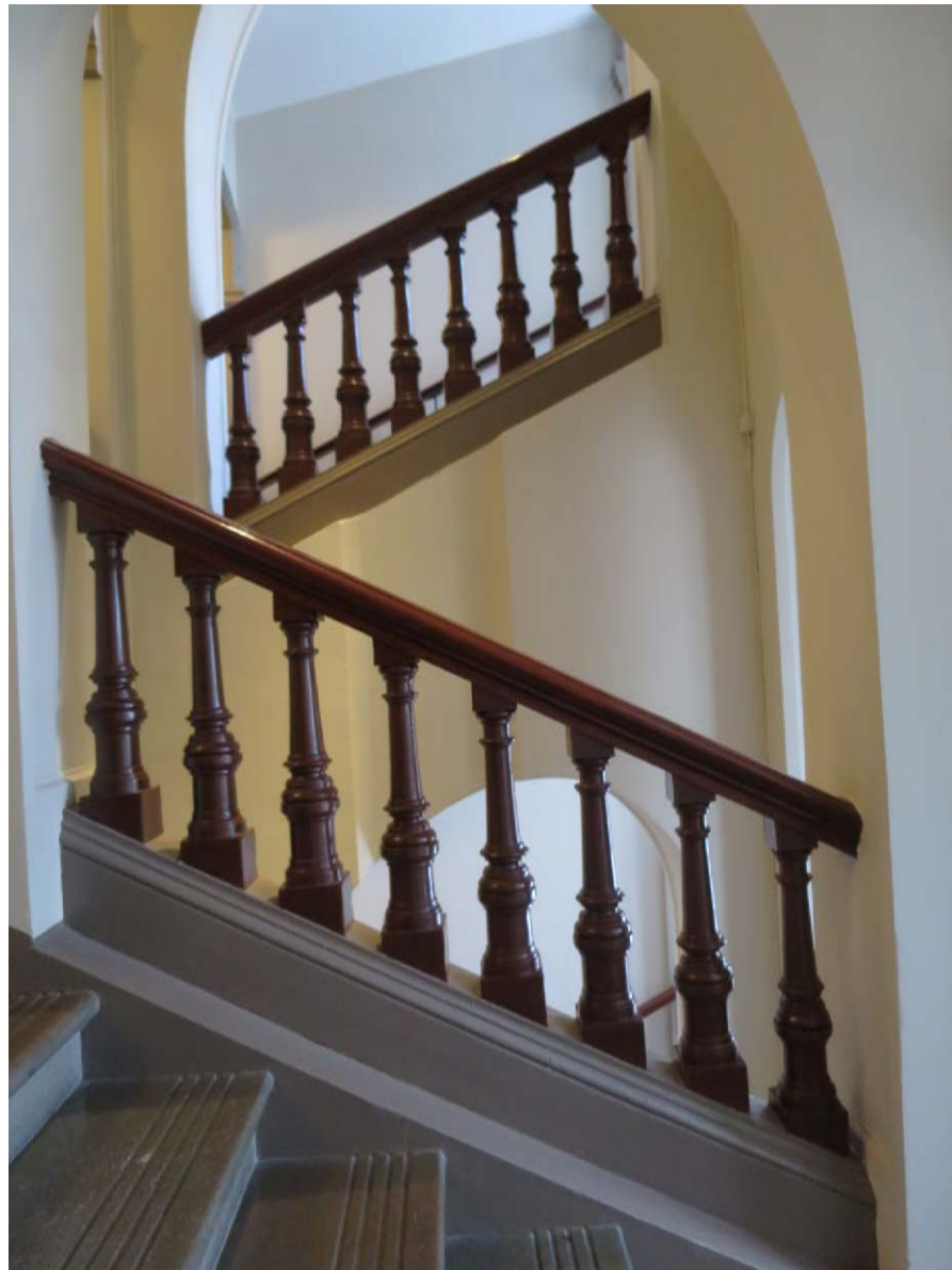
Trappräcke med svarvade balusterdockor i trappspindeln. Denna typ av räcken var vanliga i mer påkostade trapphus i slutet av 1800-talet.
