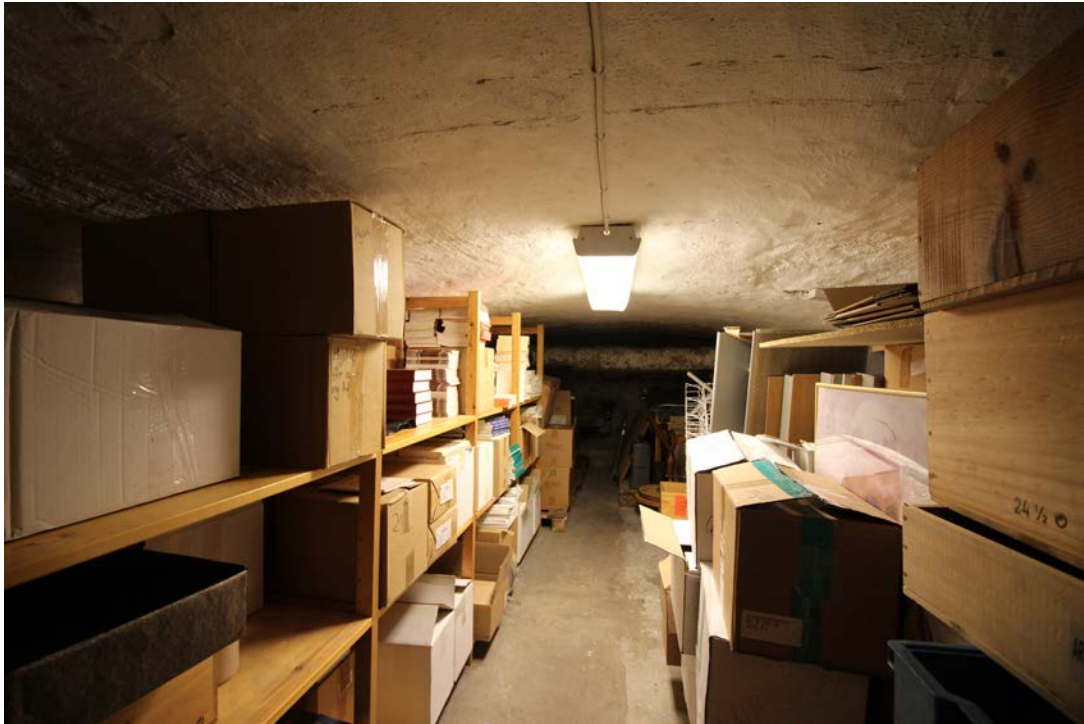
Flacka tunnvalv finns i flera av källarvåningens utrymmen.
