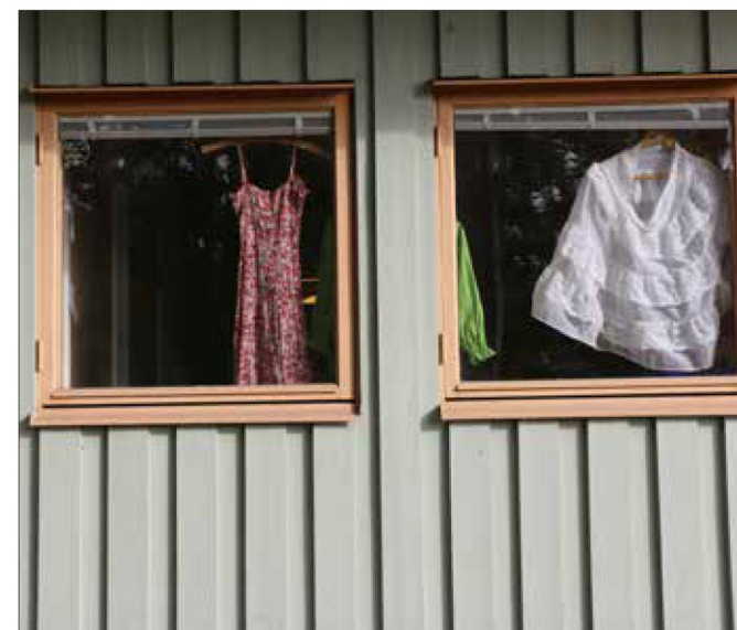
Fasader av stående lockpanel och fönster av trä.
