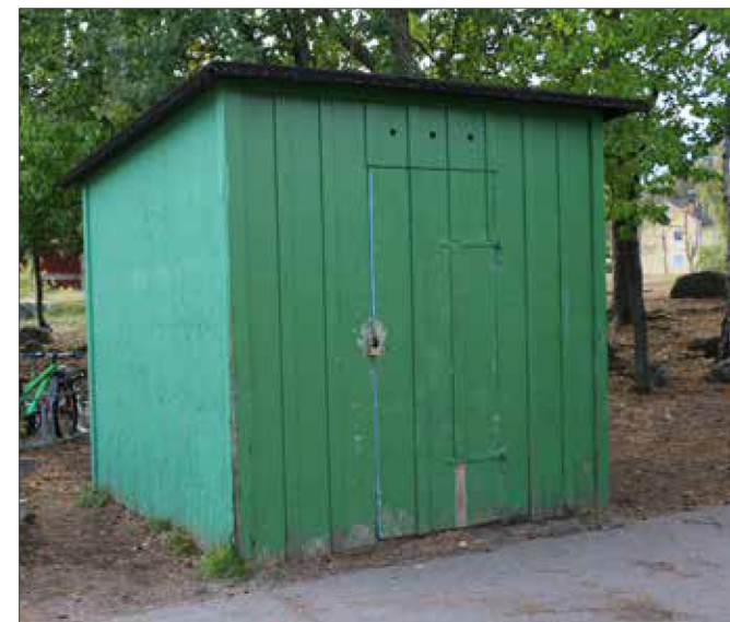
Uteförråd med locklistpanel och pulpettak. Okänt byggår.
