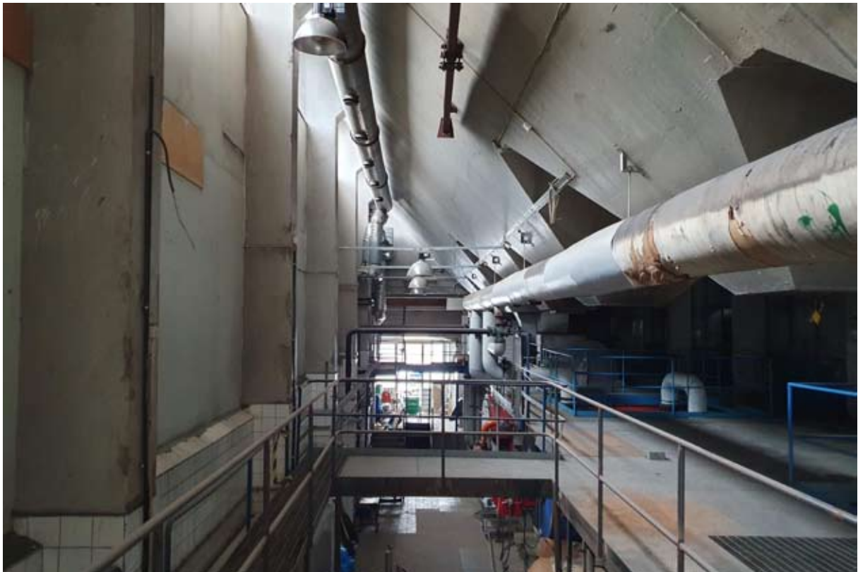
Interiör från pannrummet, med kolsilorna i platsgjuten betong synliga till höger i bild. Den vänstra väggytan mellan pelarna var ursprungligen glasad från innertaket ned till kakelbröstningen.
