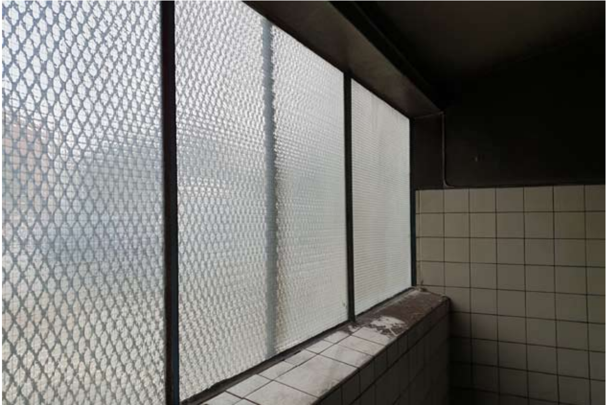
Detalj av trådglassfönster samt kaklad fönsterbänk. Exteriört sträckmetallgaller sannolikt sekundärt.
