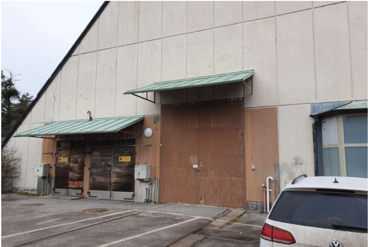
Lastportarna på södra gaveln. Portar och skärmtak förmodas vara ursprungliga, dock noteras att portarna på bygglövrutningen samtliga hade samma höjd. Notera den sekundärt bytta entréutbyggnaden som skymtar till höger.
