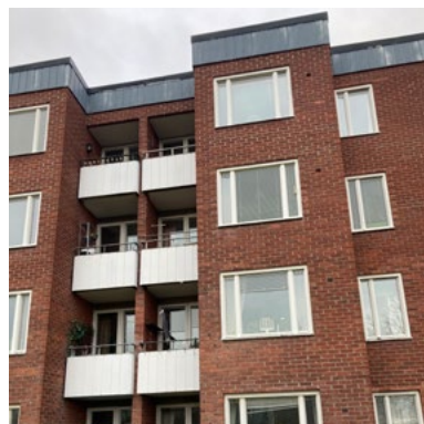
Uppbruten fasad. Indragna balkonger med murade sidostöd. Stora fönster med vädringslucka. Tak med sarg.
