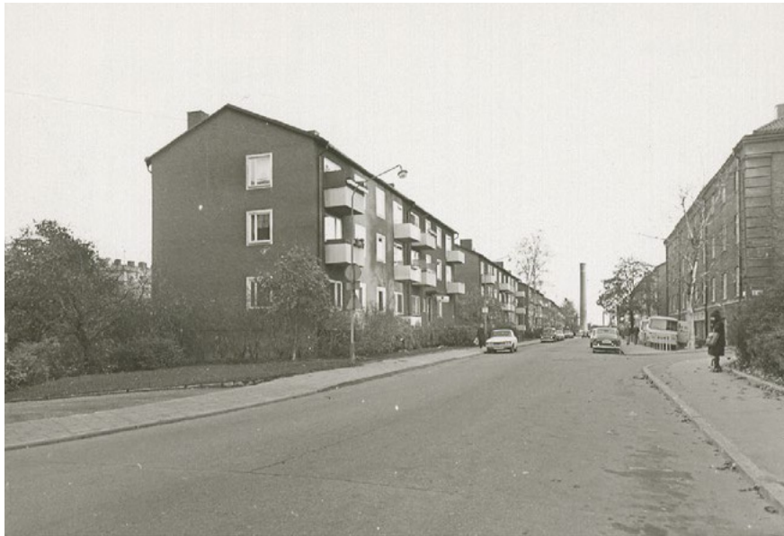
Folkhemmets flerbostadshus placerade utmed Artemisgatan. Husen har sadeltak enluftsfnster med vädringslucka. Byggnaden har småskaliga balkonger med fronter i plåt. I fonden skymtas skorsten som hör till elektricitetsverkets anläggning.
