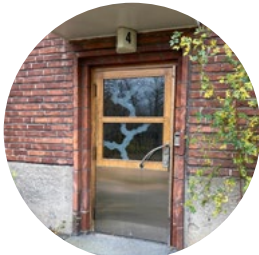
Port i trä med glaspartier. Avtrappande omfattning i tegel. Skärmtak.
