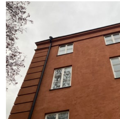
Rusticerade hörn. Profilerade gesimser. Spröjsade fönster med sex indelningar. Slammad fasad.
