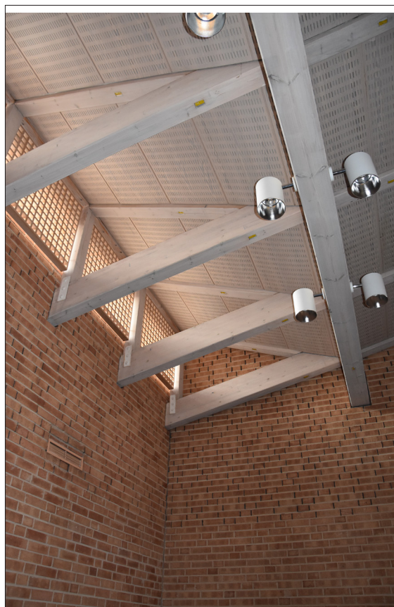
Figur 36. Detalj av tak, takstolar och ljusinsläpp
