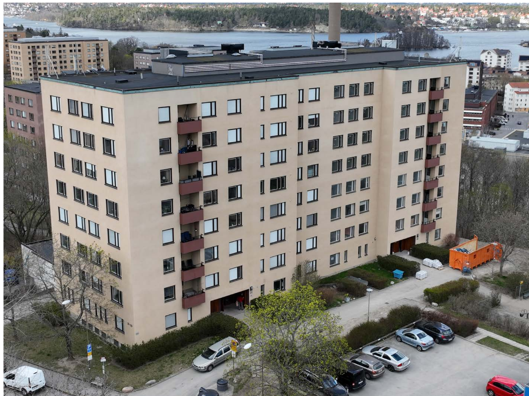
Spöksonaten 1 har renoverats under 2021-22. Nya fönster följer den ursprungliga indelningen, balkongräckena är släta plåträcken till skillnad från de ursprungliga i betong. De uppvuxna häckarna närmast fasad har kunnat sparas under renoveringsarbetena.
