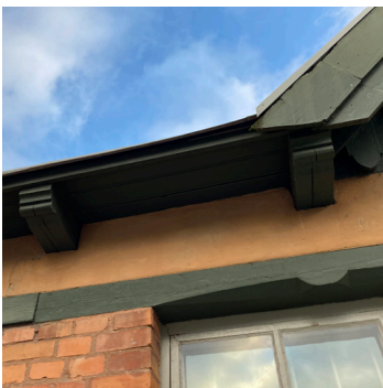
Dekorativt utformad fasaddetaljer i trä såsom vindkiva, taktassar och lister.
