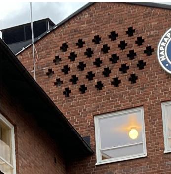
Korsformade ventilationshål
