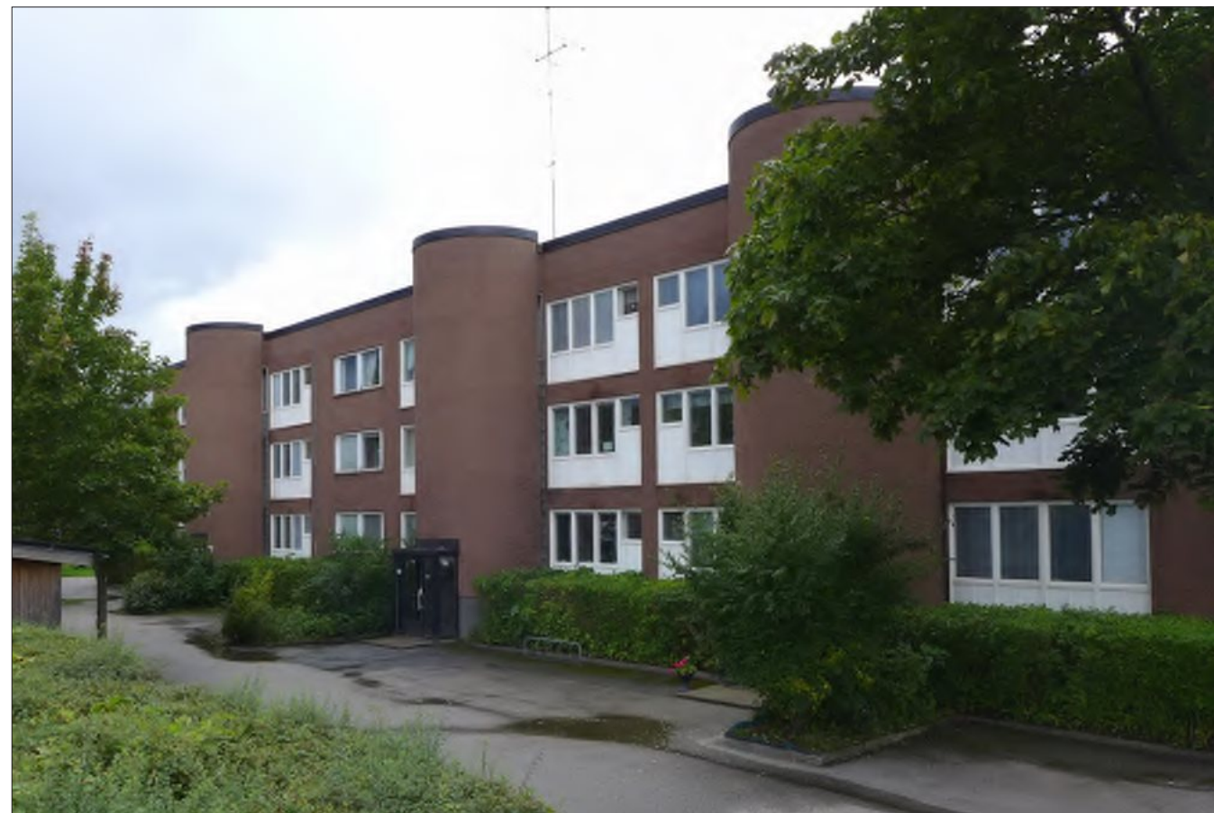
Kvarteret Bergholmens lameller har utskjutande trapphus med slitsar av glasbetong i mötet mellan trapphus och fasad.
