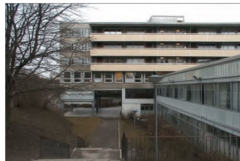
Anläggningens yttre delar utgörs av arkader. Karaktäriserande material är glas och plåt samt betongskivor med frilagd ballast. Högdelen loftgångsfasader är numera utbytta men centrumanläggningens ursprungliga karaktär är i huvudsak intakt. Fotograf Albin Dahlström, SSM.
