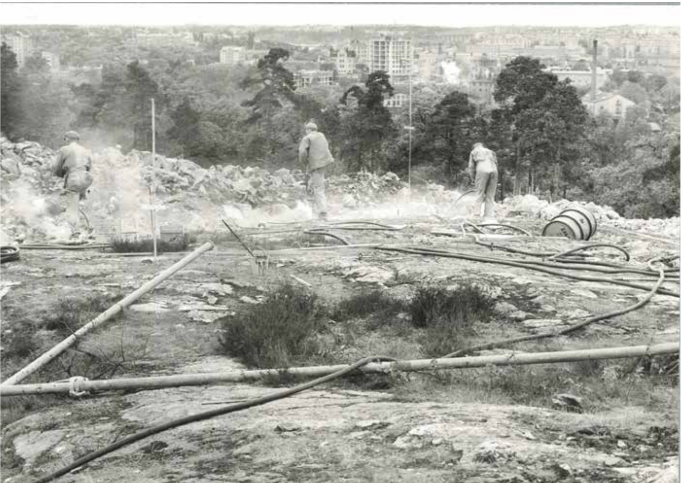
Sprängningsarbeten på Nybohovsberget för vattenledningen, foto Gunnar Södergren, okänt år, SSM.
