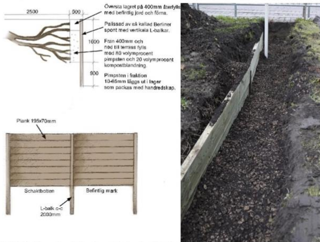
Bild 8. Skyddsspont med pimpstenssubstrat mot schaktvägg där rötter beskurits.
