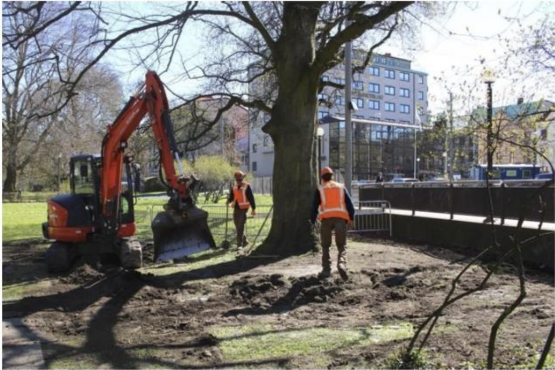
Bild 9. Avtagning av grässvål vid utförande av markvitalisering.
