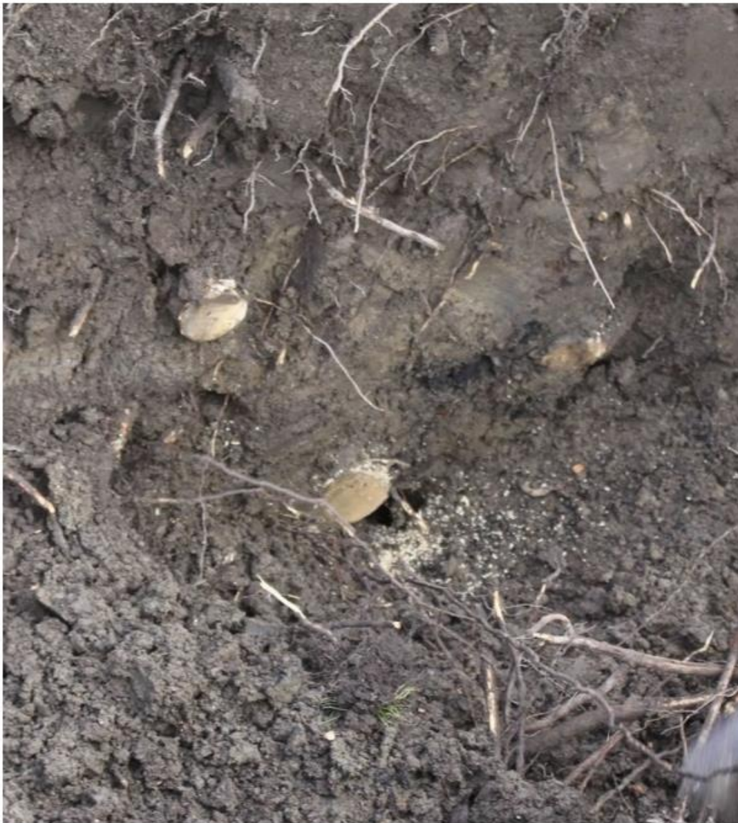
Bild 5. Korrekt beskurna rötter vid schakt.
