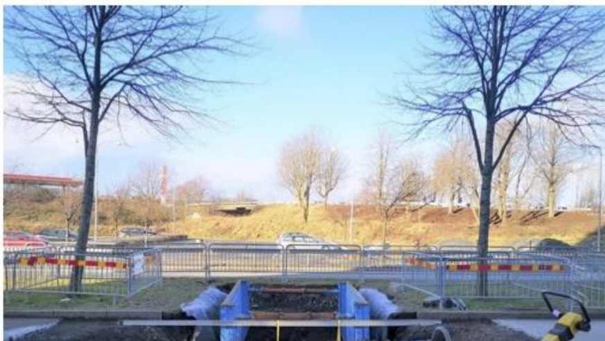
Bild 7. Användandet av spontsläde vid schakt intill träd.
