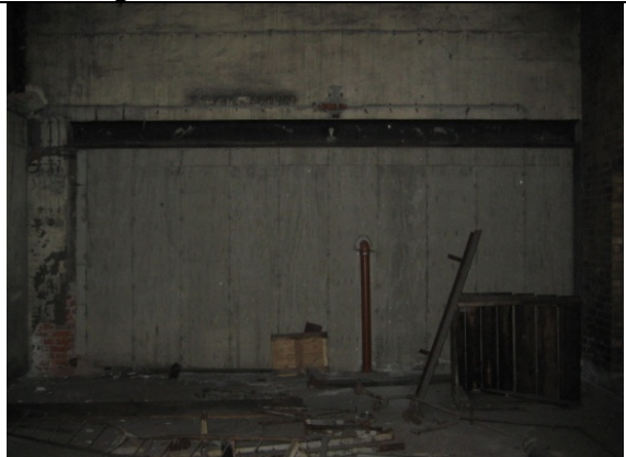
Igenmurad koksicka i källaren mot byggnad 24
