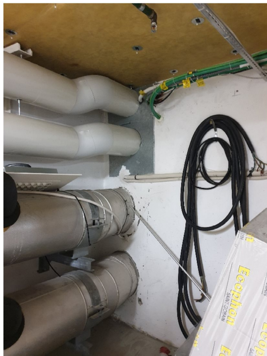
Bild 5. Inkommande fjärrvärme, fjärrkyla och fiber.
