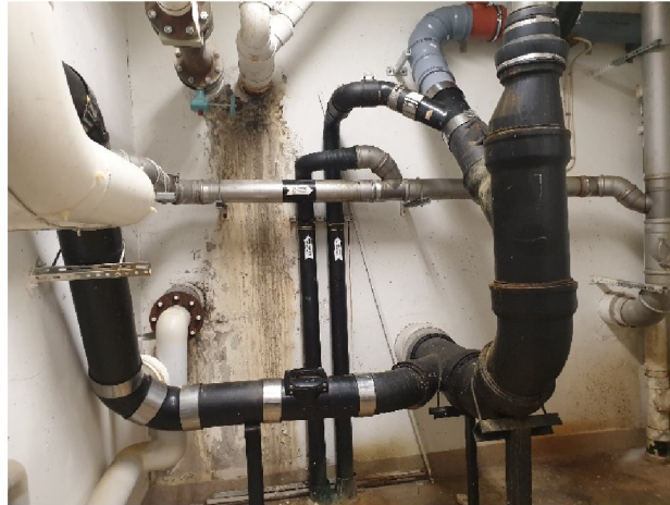
Bild 7. Utgående dag-/ och spillvatten samt inkommande kallvatten Söderhallshuset, sprinkler kapacitetsprovsledning, spillvatten till pumpgrop samt luftningsledning från pumpgrop.
