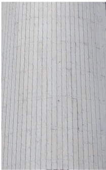
Träfasad med en jämn putsliknande karaktär i Kv Integrationen (produkt: Woodsafe Exterior WFX)
