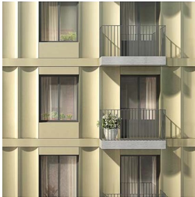
BILD 4:6:4 Detalj av fasad med profilerad eloxerad plåt.
