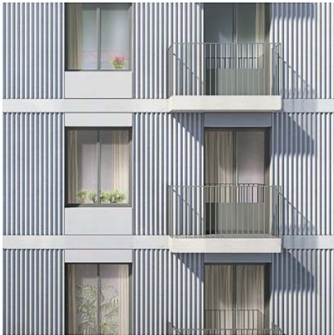
BILD 4:6:3 Detalj av fasad med profilerad målad betong.
