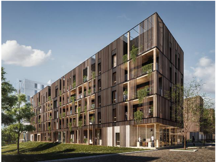
RIBBOR Loftgången kläs i ribbor av trä. Detta gör att fasaden upplevs som öppen och inbjudande från en riktning samtidigt som den upplevs som mer avskilt och privat från den andra riktningen. Referens: Fluvial eco-district of Ile-Saint-Denis, Athletes' Village
