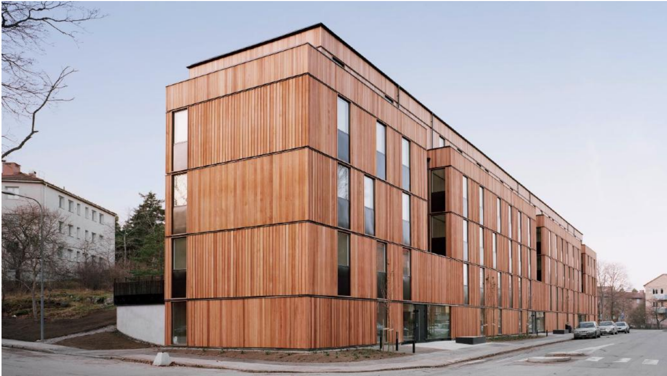
SKAGERSHUSET, ÅRSTA Flerbostadshus i trä med tidlös arkitektur i Årsta, byggt i trämoduler och med brandimpregnerade fasad i cederträ.
