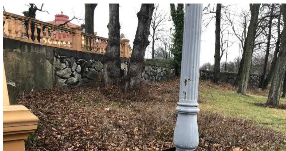
Äldre terrassmur med nyare pågjutningar av betong. Muren ligger i anslutning till den nuvarande parkeringsplatsen. Fram till 1963 låg Gubbhyllan på platsen och muren är uppförd i anslutning till denna.
