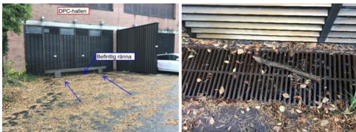
Figur 6. Serverhallens södra fasad, när den befintliga rännan är vattenfylld blir vatten stående på markytan och rinner in i byggnaden.
