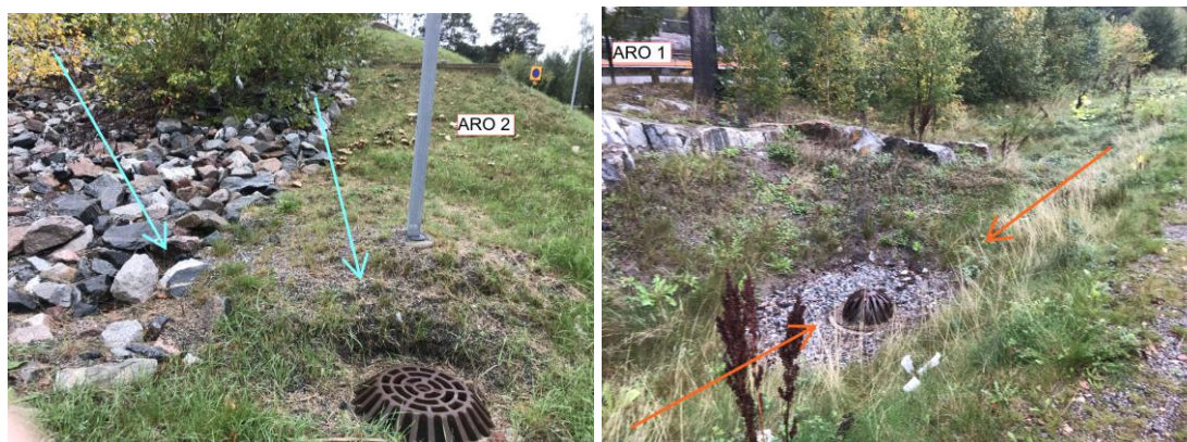
Figur 6. Till vänster: Befintlig kupolbrunn vid korsningen Lagtingsgatan/Kista Allé väg som leder ARO 2 till befintligt ledningsnät i Lagtingsgatan. Till höger: Befintligt dike mellan parkeringen och Surtsögatan. Diket är en del av avvattningsystemet inom ARO 1.
