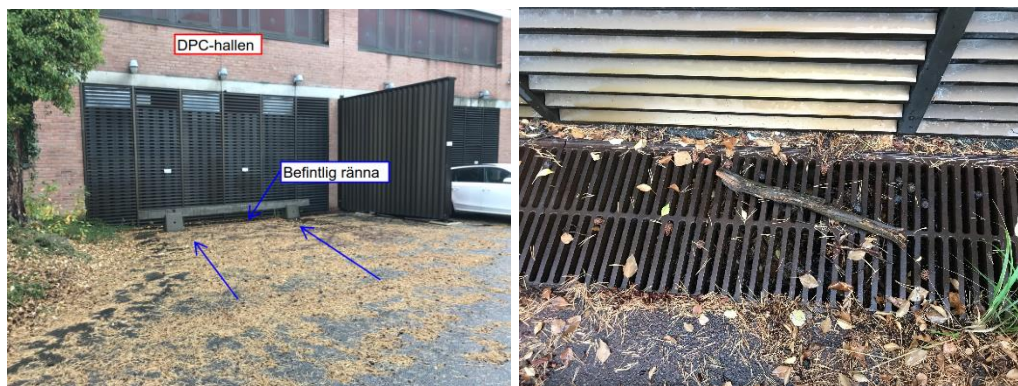
Figur 27. Befintlig lågpunkt söder om DPC-hallen. Dagvatten från parkeringen mellan Ormen lång och DPC-hallen rinner mot rännan vid DPC-hallen. Här kan det bli problem vid skyfall när rännan fylls.
