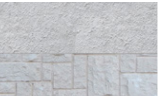
Illustrativ bildmontage som visar materialmöten mellan puts och keramiska material med olika typer av plattor.
