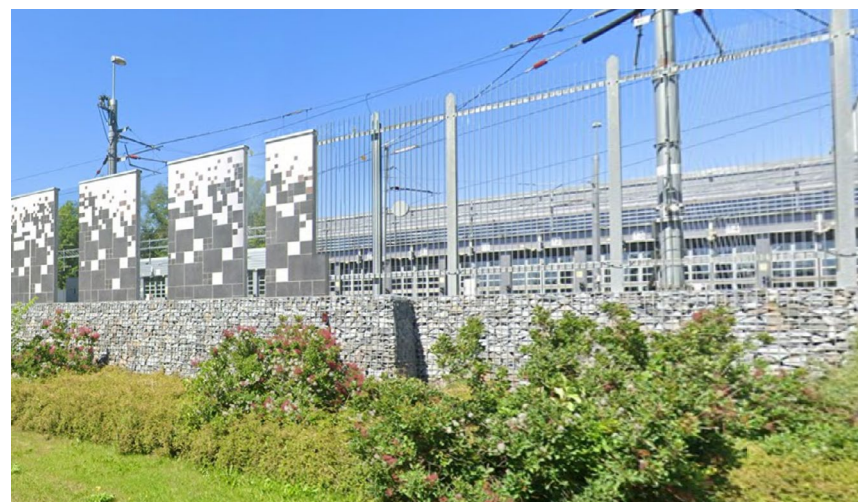
2.3.4 Ett exempel för skalskydd vid depåområdesgräns, Ulvsundadepån.
