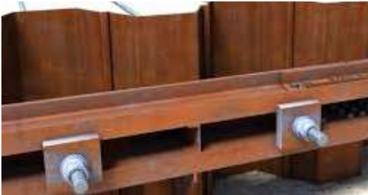
Princip för horisontella stag och hammarband
