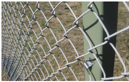
Fallskydd av nät, vid spont typ flätverk, galvaniserat. Synlig höjd 1.10 m
