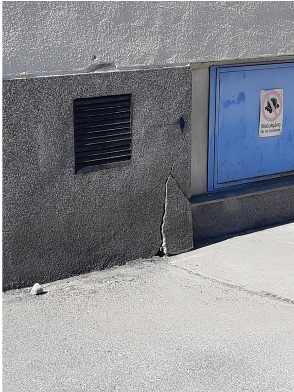
Figur 6: Skador på fasad och sättning vid stödmur söder om Skattegårdsvägen.
