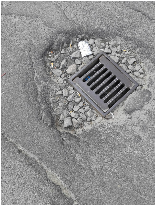
Figur 7: Skador vid dagvattenbrunn och skador på gator i kvarteren söder om Skattegårdsvägen.
