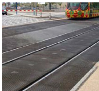
Figur 12 Strails i gatukorsning (vignolräl)
