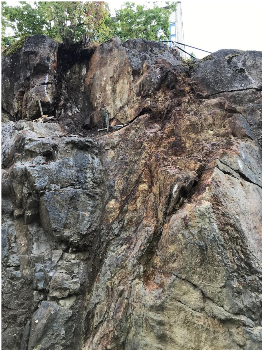
Figur 5. Bild tagen från delområde 4s där svaghetszonen löper nästintill vertikalt i bild samt tidigare förstärkningsåtgärder synliga i bildens övre vänstra område.
