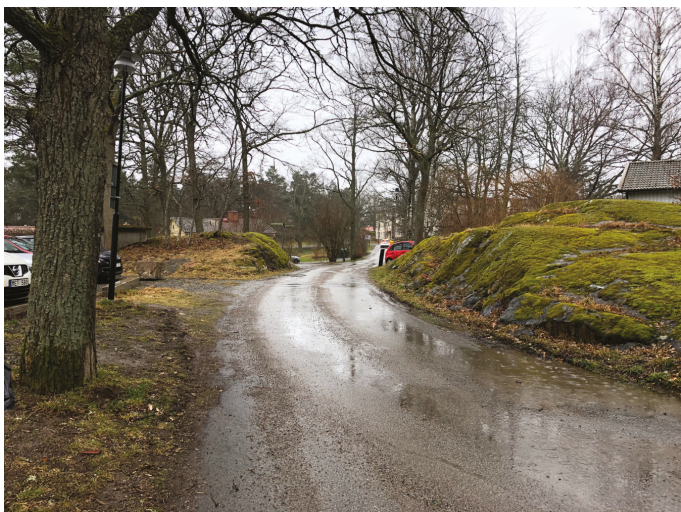
Väg framdragen genom ett bergsparti. Genom noggrann sprängning som har följt bergets struktur så är åtgärden idag knappt märkbar.
